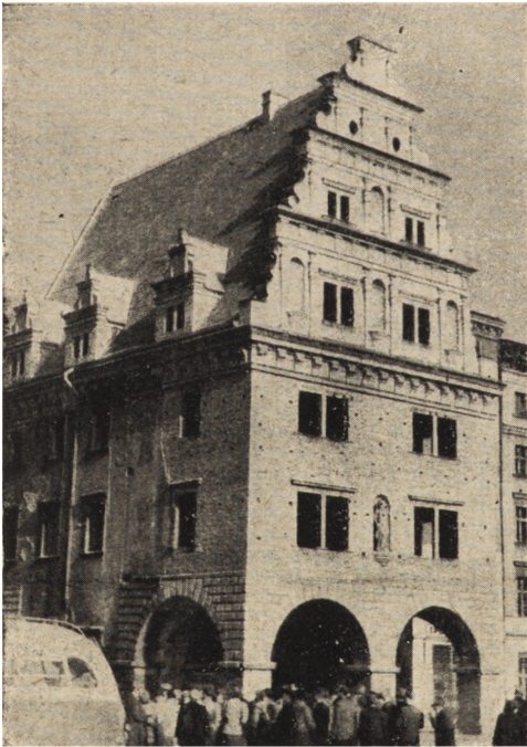
Ryc. 326. Nysa — budynek Wagi miejskiej podczas odbudowy.
