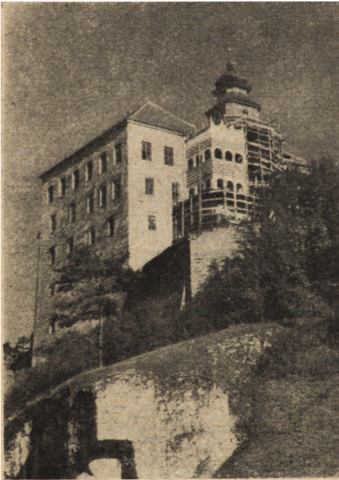
Ryc. 322. Pieskowa Skala — zamek. Widok na nowoodkrytą loggię.
