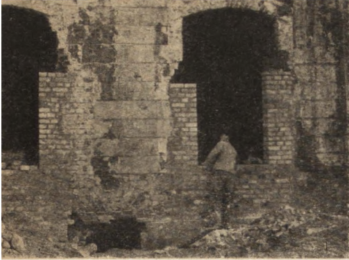
Ryc. 329. Białystok — ostrołukowe okno piwnicy w fasadzie ogrodowej pałacu.
