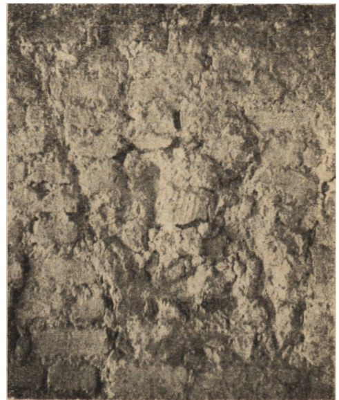
Ryc. 331. Białystok — ślad oporu sklepienia w sieni pałacowej. Widoczna cegła palcówka.
