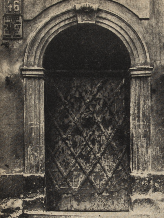
Ryc. 143. Portal z I poł. XVIII w. przy ul. Piwnej 46.
