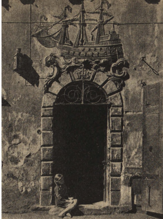
Ryc. 138. Portal z XVII w. z usuniętymi impostami i dekoracją narzutową z XVIII w.
