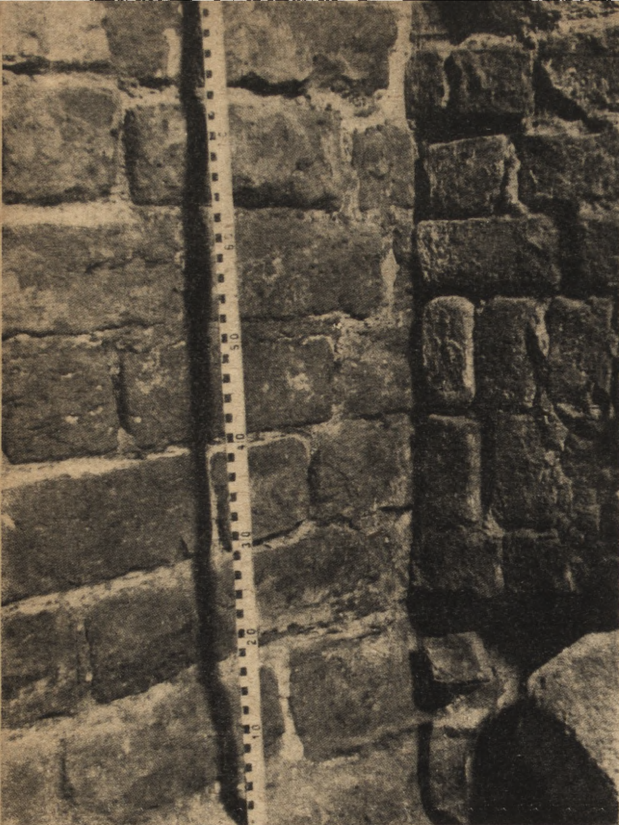
Ryc. 214. Fragment muru obronnego z dobudowaną ścianą kamienicy przy ul. Brzozowej 7.
