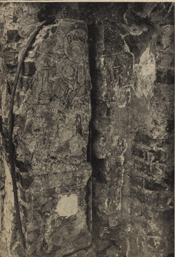
Ryc. 218. Ujęcie części malowidła w obręcz z płaskownika.
