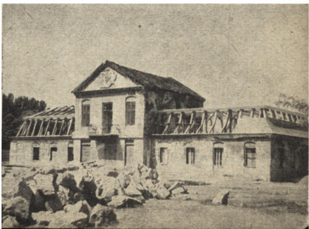
Ryc. 65. Kraków — stary zajazd, ul. Białoprowadnicza 3. Stan z r. 1952 w czasie robót konserwatorskich.
