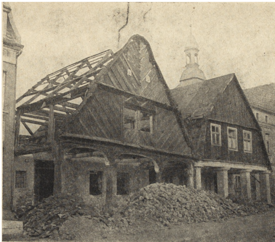
Ryc. 119. Domy Rynek 40 i 41. Stan z r. 1951 w chwili rozpoczęcia prac.
