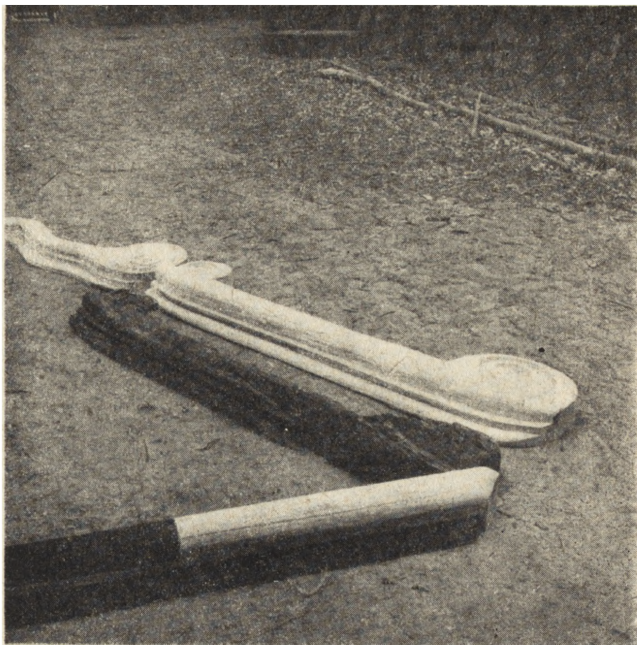
Ryc. 121 i 122. Rynek 40. Rekonstruowane elementy szczytu i odsłonięta belka stropowa izby od podcienia.
