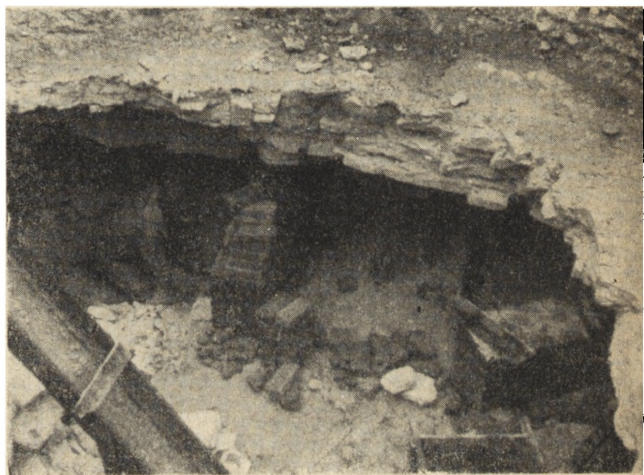
Ryc. 131. Krzemionki Opatowskie — zabezpieczanie szybu górniczego.
