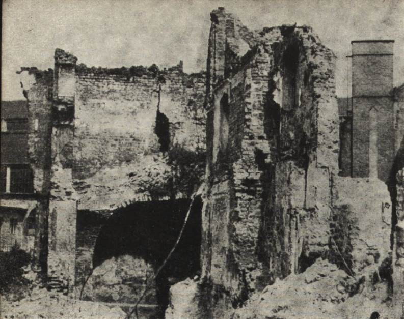
Ryc. 14. Widok wieży od południowego zachodu.
