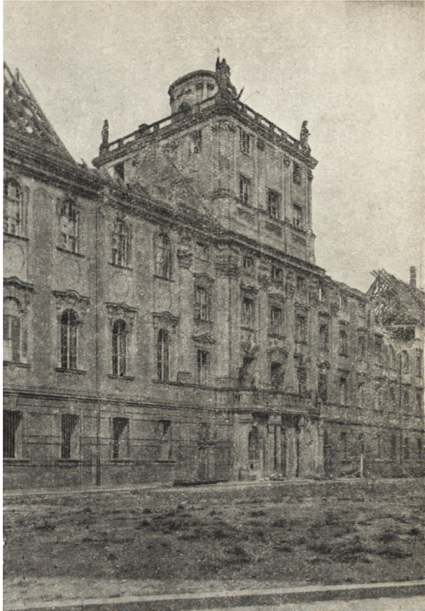
Ryc. 37. Wrocław — Uniwersytet. Stan zniszczenia.
