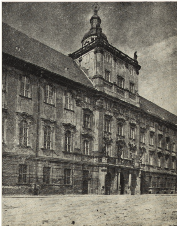
Ryc. 38. Wrocław — Uniwersytet w czasie odbudowy w 1948 r.
