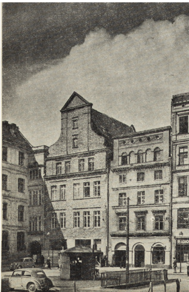
Ryc. 36. Wrocław, dom zabytkowy przy pl. Solnym 11 w czasie odbudowy.
