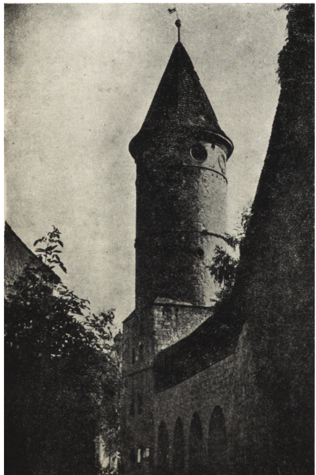
Ryc. 40. Lwówek — baszta i mury miejskie po zabezpieczeniu.
