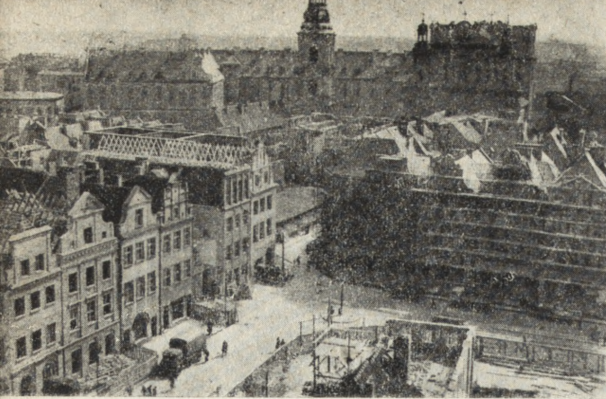
Ryc. 124. Rynek w Poznaniu w czasie odbudowy. Stan z r. 1955.
