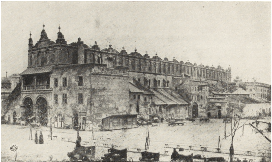
Ryc. 156. Sukiennice — strona zachodnia. Stan z r. 1869 przed przebudową Prylińskiego.
