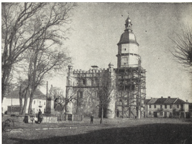
Ryc. 106. Prace przy rekonstrukcji wieży ratuszowej w Szydłowcu.
