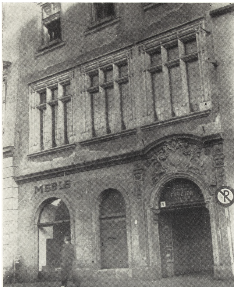
Ryc. 40. Kamienica Bonerów po przeprowadzonej restauracji okien I piętra w 1942 r.
