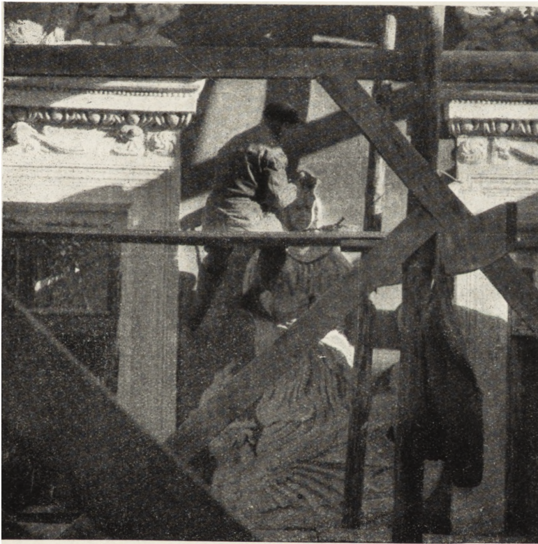
Ryc. 20. Kamienica „pod Madonną”, ul. Ormiańska 22 — prace konserwatorskie przy wystroju rzeźbiarskim.
