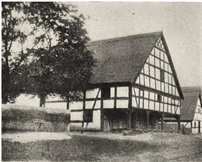
Ryc. 25. Ryszewo (pow. Pырzyce) — dom wąskofrontowy z 1790 r.
