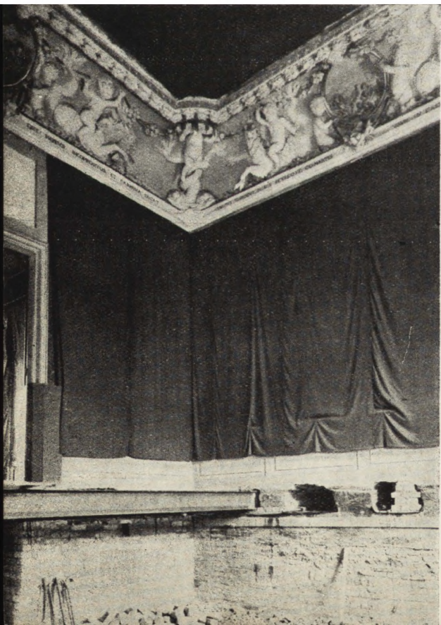
Ryc. 63 i 64. Pałac w Wilanowie — widok fasady i sypialnia króla podczas prac konserwatorskich (1956).
