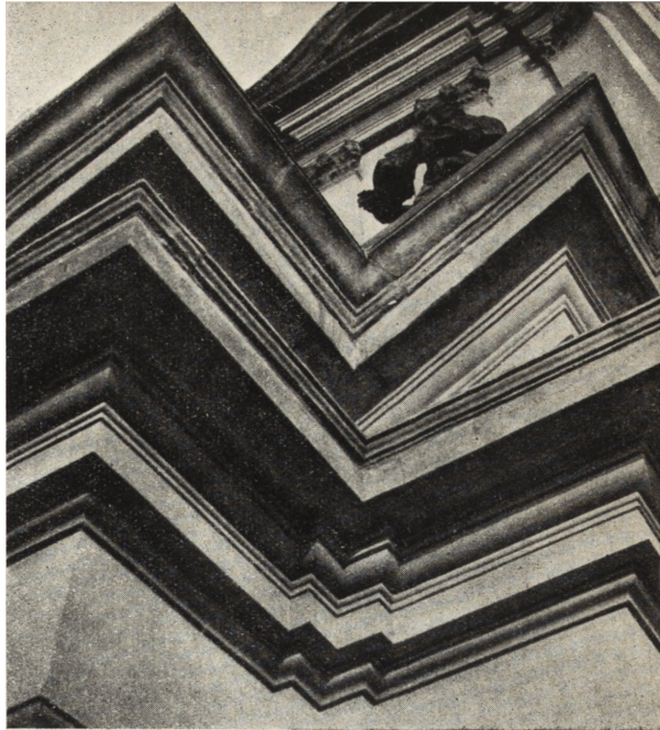
Ryc. 69. Warszawa — Kościół Wizytek. Gzyms II kondygnacji fasady po konserwacji (1956).
