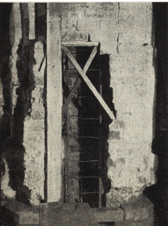
Ryc. 68. Kościół N. M. Panny — zbrojenie słupa żelbetowego wewnątrz filaru nawy półu. (1956).
