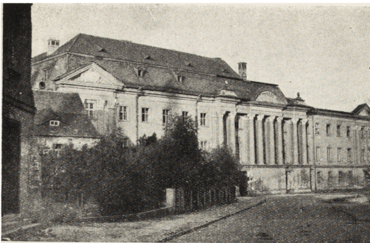
Ryc. 7. Zary — pałac. Jeśli przez kilka jeszcze lat pozbawiony będzie użytkownika, zamieni się w ruinę.
