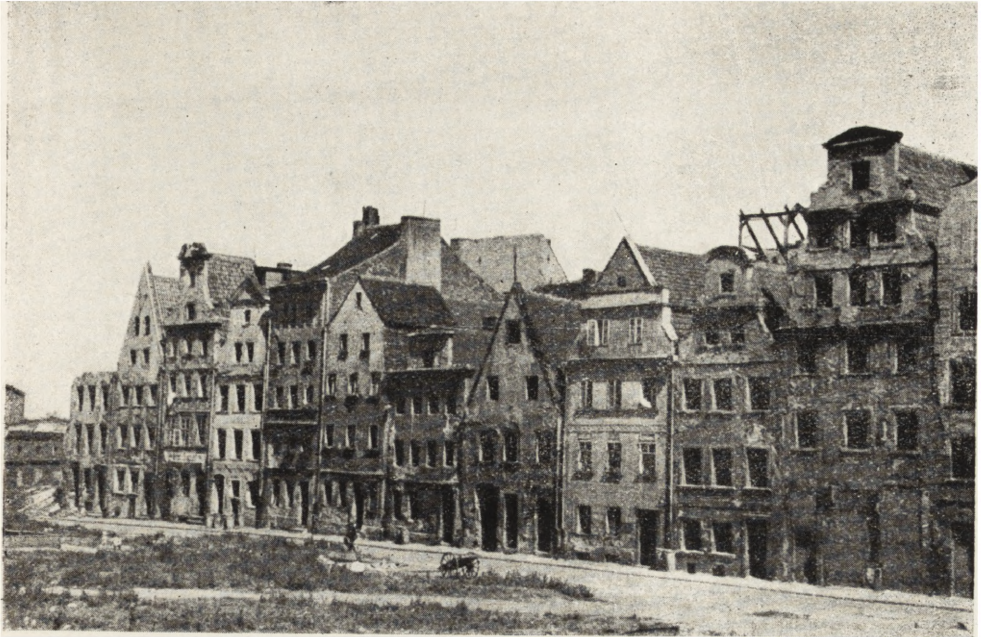
Ryc. 5. Wrocław — opuszczone przez mieszkańców zabytkowe domy mieszkalne.
