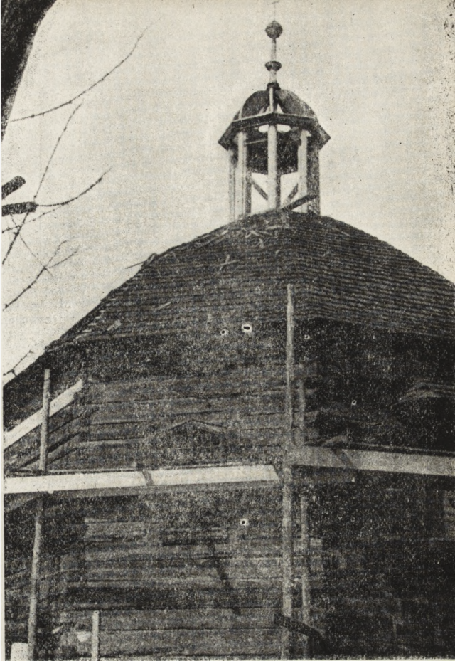
Ryc. 235. Salwator — kaplica św. Małgorzaty w czasie robót konserwatorskich w 1957 r.
