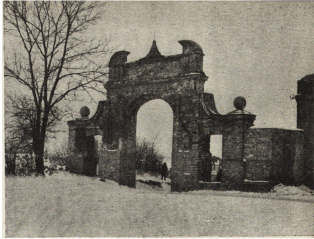
Ryc. 122. Zawieprzycze — brama wjazdowa po zabezpieczeniach w 1956 r.
