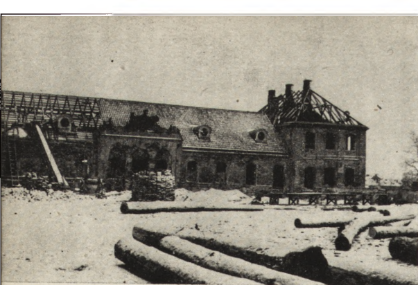
Ryc. 119. Radzyń — wschodnie skrzydło pałacu w czasie odbudowy, 1957.
