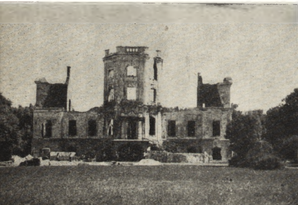
Ryc. 120. Łabunie, pow. Zamość — elewacja frontowa pałacu, 1957.
