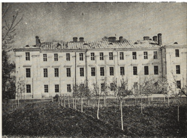
Ryc. 117. Opole Lubelskie — elewacja pd. pałacu Lubomirskich, 1955.
