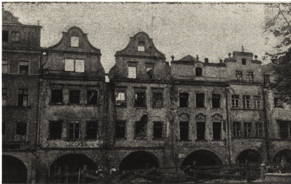
Ryc. 200. Jelenia Góra. Elewacje kamienic rynkowych (nr nr 12, 13, 14, 15), stan w 1936 r.
