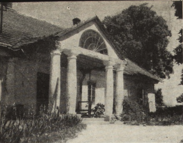
Ryc. 258. Garlica Murowana, pow. krakowski — dwór przed konserwacją. Stan z r. 1956.
