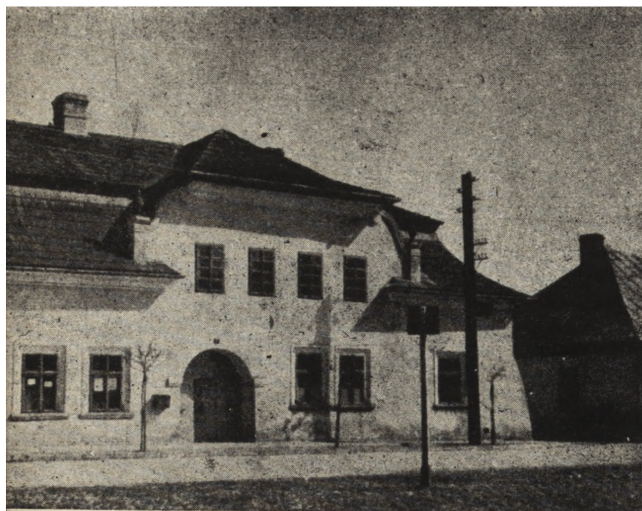
Ryc. 252. Stary Sącz — tzw. „Dom na Dołkach”. Stan po konserwacji 1957 r.
