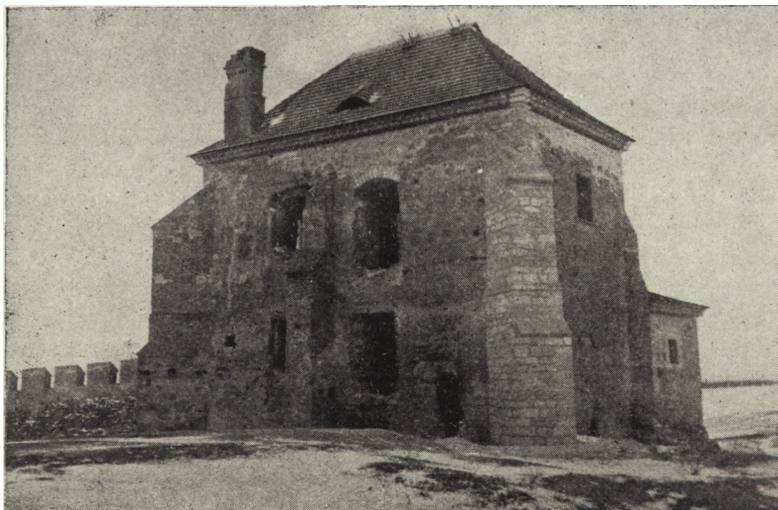
Ryc. 28. Szydłów. Skarbczyk w odbudowie, stan w kwietniu 1958 r.
