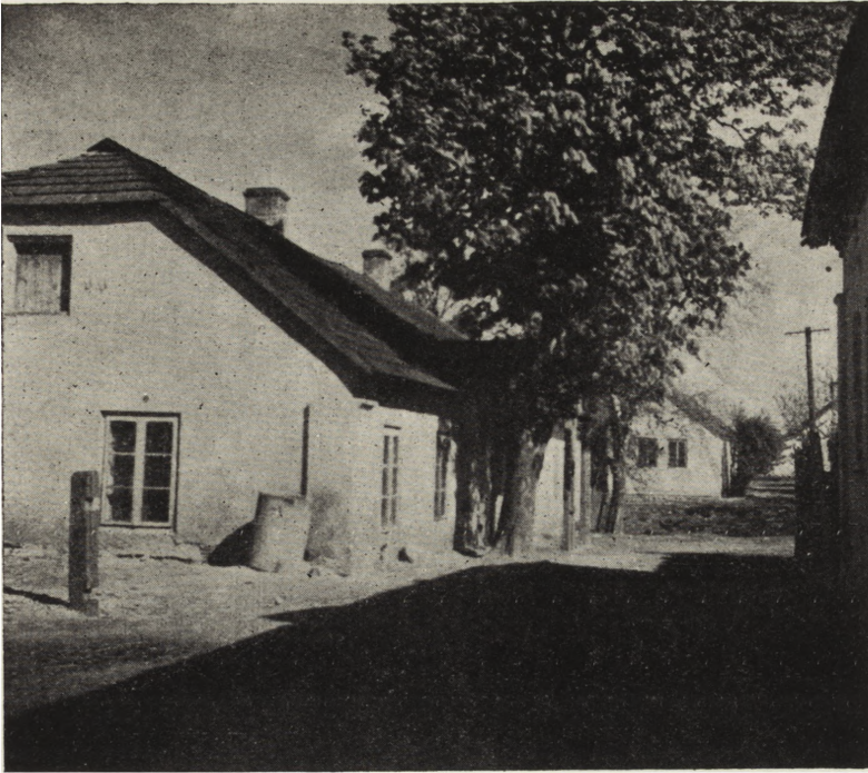
Ryc. 26. Szydłów. Ul. Kazimierza Wielkiego. Budynek GRN. 1957.
