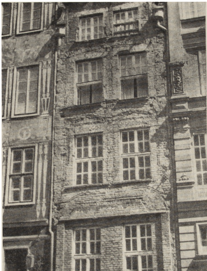
Ryc. 116. Długa 71. Kamieniczka oddawna bezskutecznie oczekuje na doprowadzenie do porządku jej szczęśliwie zachowanej pod późniejszymi przemurowaniami i tynkami gotyckiej fasady. A projekt już dawno jest gotowy...
