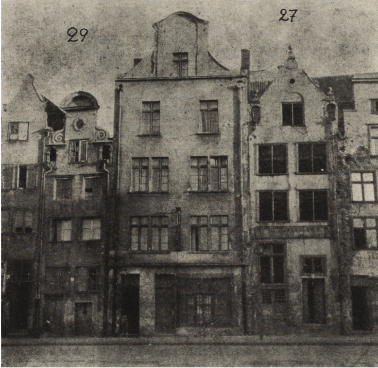
Ryc. 115. Kamieniczki barokowe przy ul. Straganiarskiej: nr 27 (z 1649 r.) i nr 29 (z 1712 r.). Zdjęcie z 1956 r., na którym obie już są w b. złym stanie.
