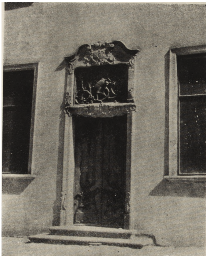
Ryc. 121. Portal z ul. Piwnej 13, który po długiej wędrówce został osadzony w przyziemiu rokokowej kamieniczki Długi Targ 29. Piękny przykład portalu rokokowego z II poł. XVIII wieku i... solidnej roboty konserwatorskiej.
