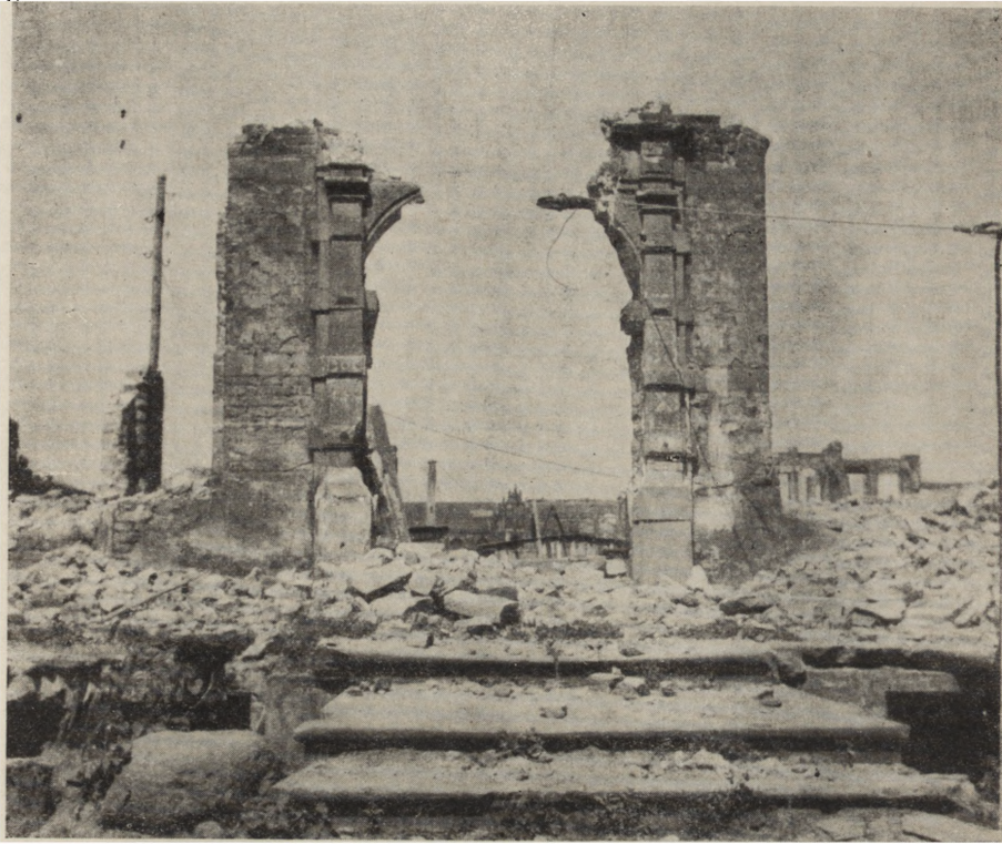
Ryc. 119. Chlebnicka 29. Po wojnie zachowała się pozbawiona szczytu piękna renesansowa fasada z pocz. XVII w. Zimą z 1955/1956 zwalono mury, tak że pozostały tylko resztki portalu. Teraz kamieniczka jest już odbudowana w stanie surowym, a resztki portalu są, ale w lapidar.um. Zdjęcie z 1956 r.
