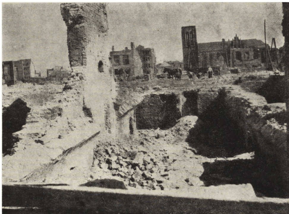
Ryc. 125. Zburzone stare sklepienia jednej z piwnic przy ul. Chlebnickiej. Zdjęcie z 1956 r.
