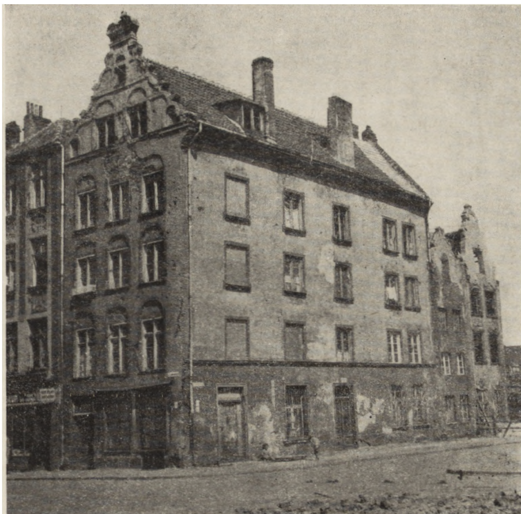
Ryc. 113. Lawendowa 1 — renesansowa kamieniczka wymagająca natychmiastowego remontu. Na prawo dwie kamieniczki barokowe przy ul. Świętojańskiej 69/70 — już nie istniejące. Zdjęcie z 1956 r.
