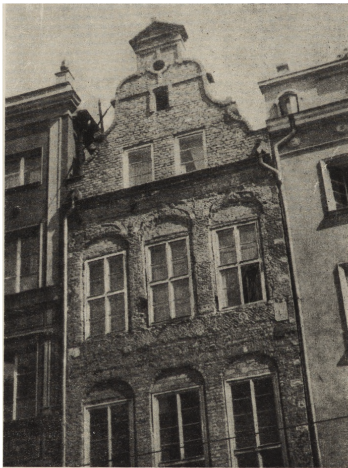
Ryc. 117. Długa 74. Kamieniczka od dawna bezskutecznie oczekuje na doprowadzenie do porządku jej szczęśliwie zachowanej pod późniejszymi przemurowaniami i tynkami wczesnorenesansowej fasady. A projekt rekonstrukcji jest już od dawna gotowy...
