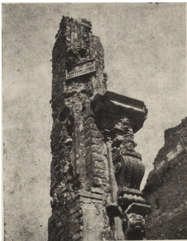
Ryc. 118. Chlebnicka 27. Zachowany szczątek fasady z gotyckimi profilami i pilastrem renesansowego portalu. U góry widoczna tabliczka ochronna umieszczona przez Zakład Historii Architektury Polskiej Politechniki Gdańskiej. Zdjęcie historyczne z 1956 r.
