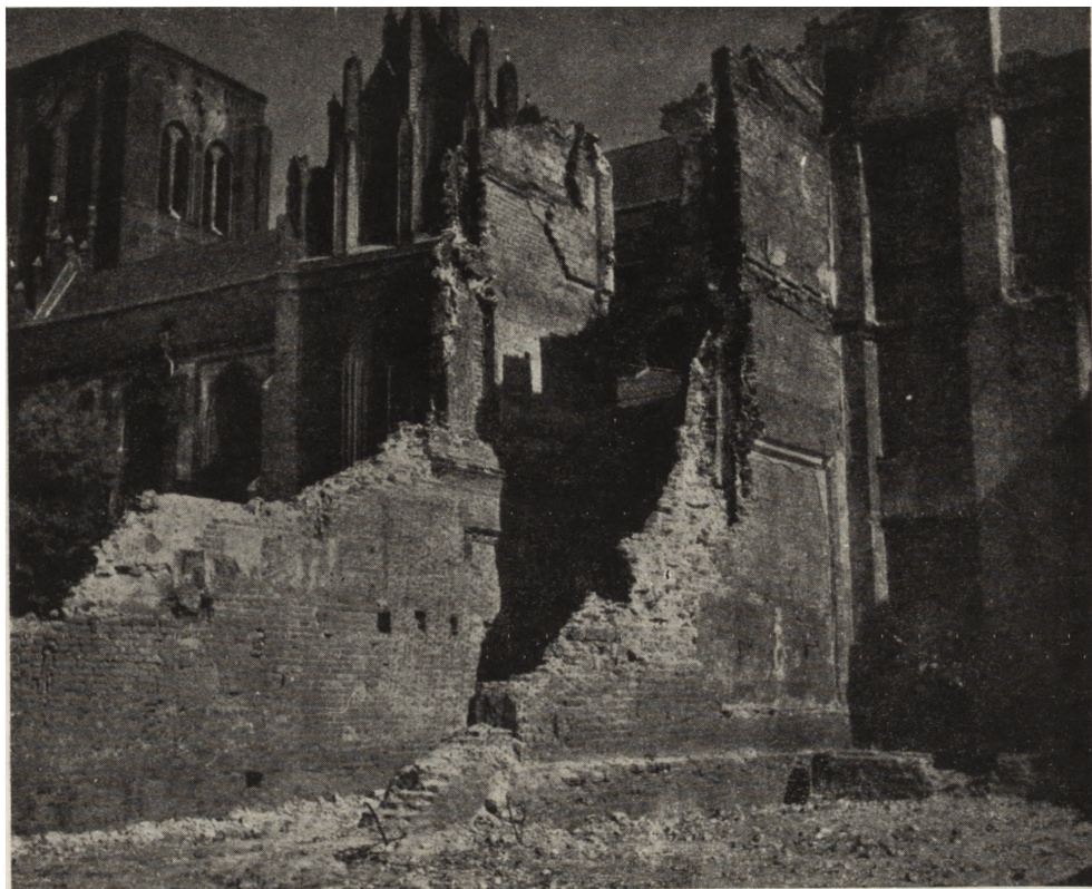
Ryc. 124. Świętojańska 36/37. Gotyckie mury działowe z prostokątnymi wnękami sieni. Widok od wnętrza bloku. Zdjęcie z 1956 r. — niestety, już historyczne...
