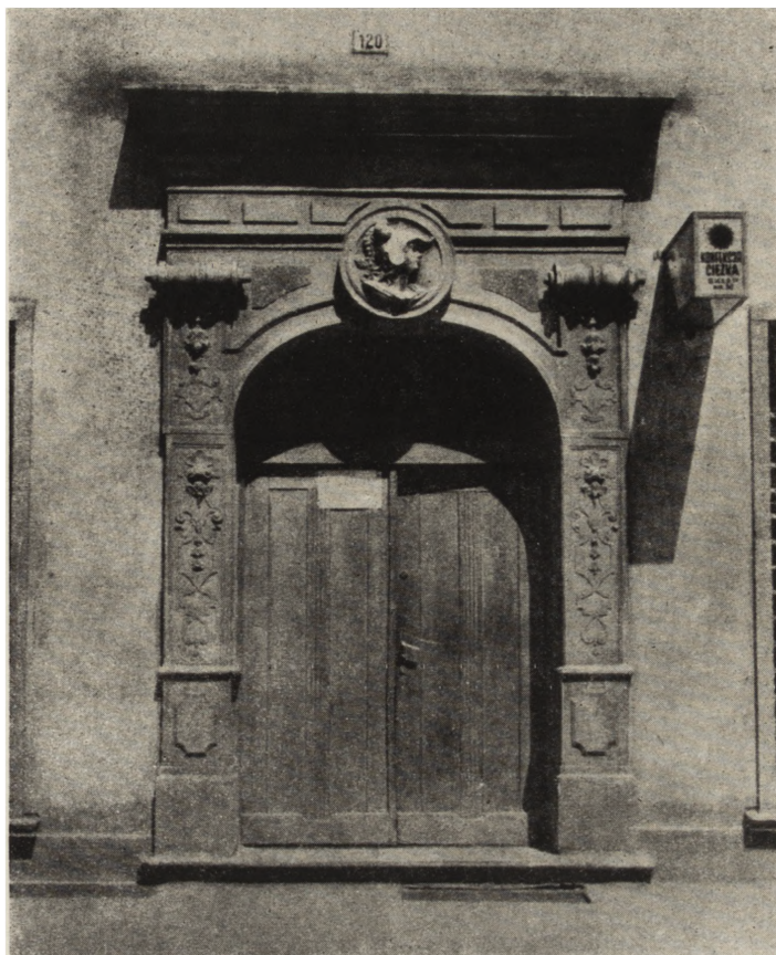
Ryc. 122. Ogarna 10. Portal przeniesiony w 1949 r. do kamieniczki nr 120. W czasie montażu omykowo umieszczono pod gzymsem główce pilastrów. Ale portal uratowano...
