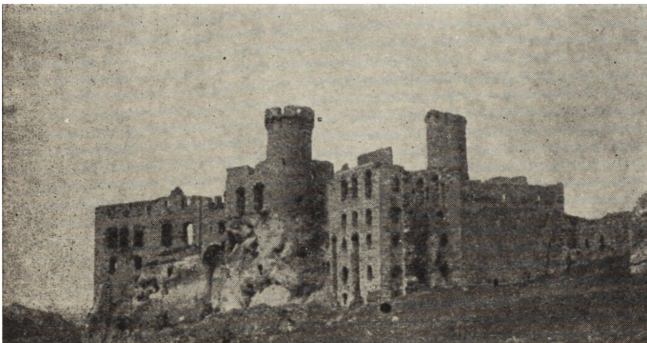
Ryc. 224. Ogrodzieniec, woj. katowickie. Zamek, elewacja południowo-wschodnia.
