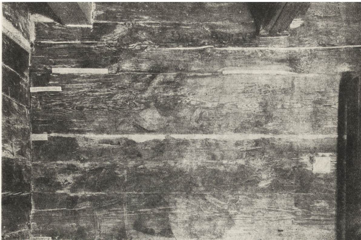
Ryc. 7. Nawa pn., św. Marcin — w toku konserwacji po zakitowaniu i wklejeniu fleków. (fot. Pracowni Konserwacji Zabytków)
