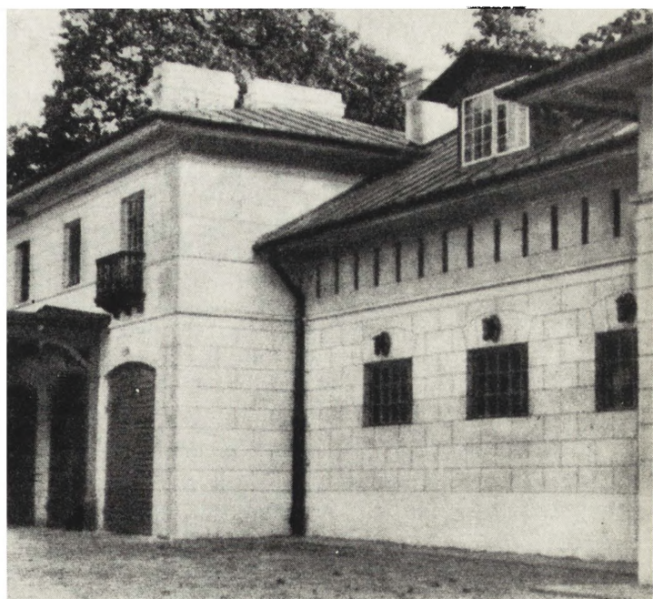
Ryc. 14. Fragment budynku stajni pałacowej, stan po zakończeniu prac konserwatorsko-budowlanych (fot. B. Seredyńska)
