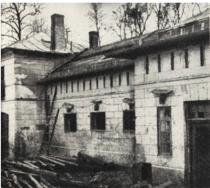
Ryc. 13. Fragment budynku stajni pałacowej, stan w czasie robót konserwatorsko-budowlanych (fot. PKZ)
