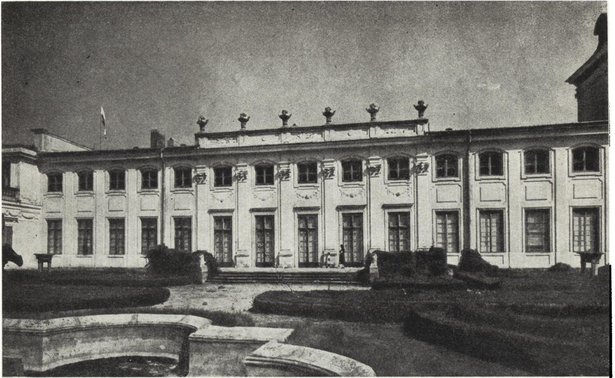
Ryc. 6. Skrzydło południowe, elewacja ogrodowa, stan przed konserwacją z nieistniejącą attyką płytowo-azurową (fot. PKZ)
