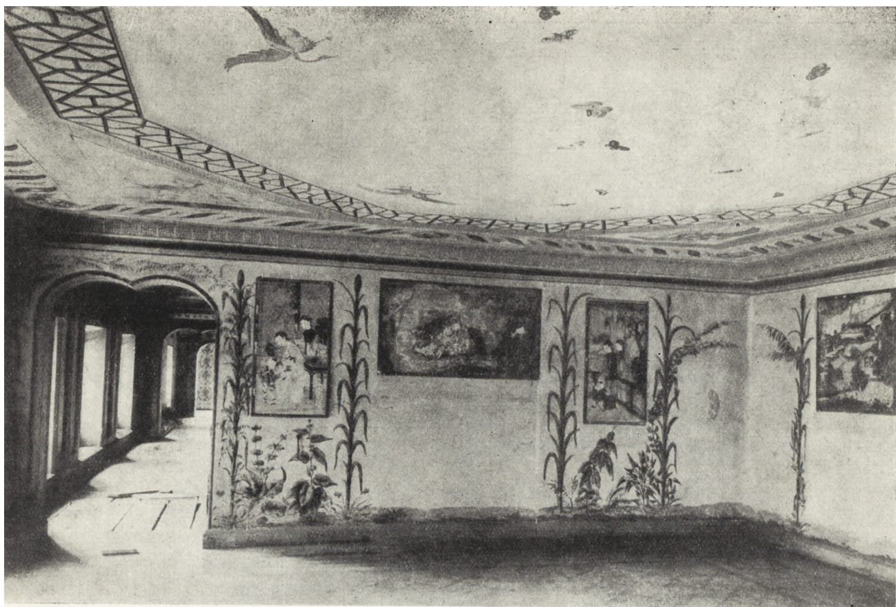
Ryc. 20. Przedpokój, ściana południowa, stan przed konserwacją
