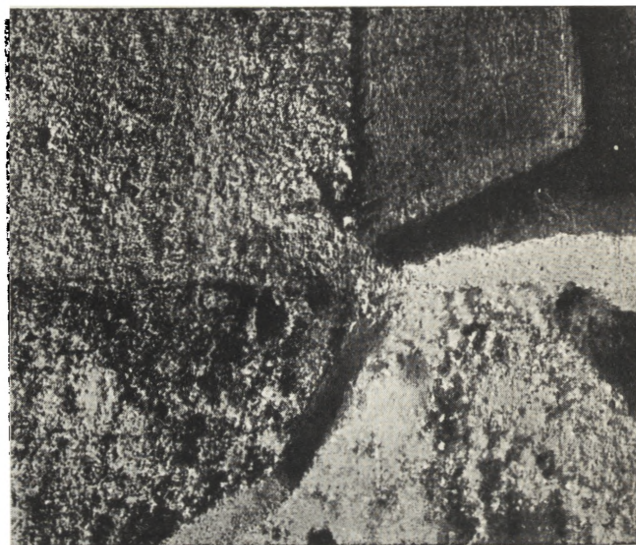
Ryc. 5. Pyzdry, klasztor, wykwit soli potasowych na scenie nr 13 (fot. H. Grzesikowa)
