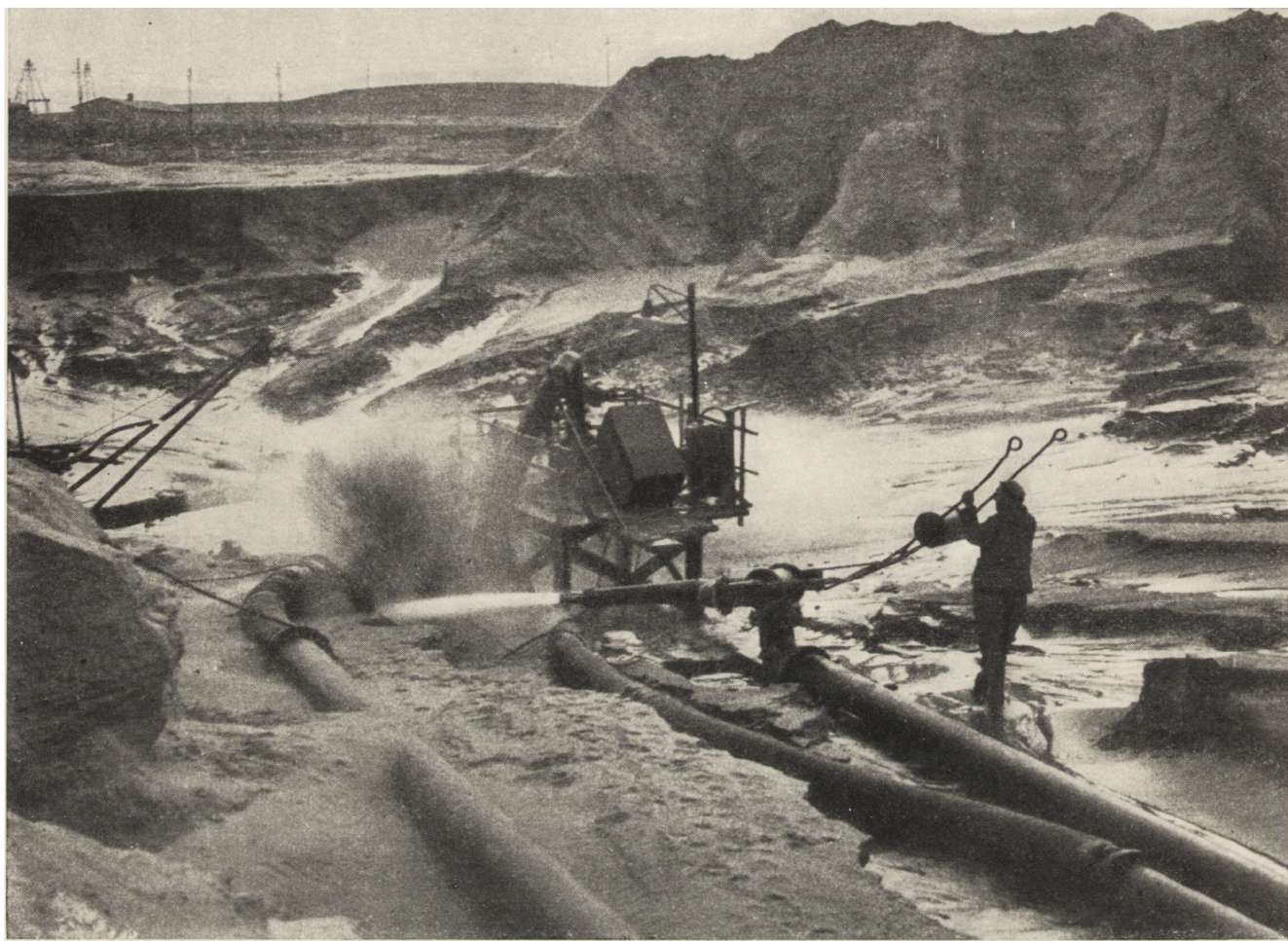
Ryc. 2. Prace hydroeksploatacyjne, na drugim planie zwały piasku nagromadzonego przez spychacze na krawędzi wybierzyska
