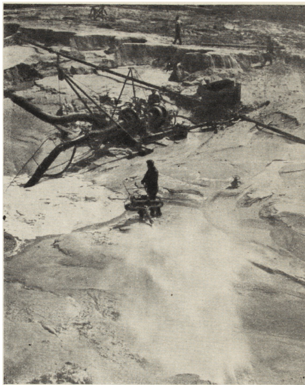
Ryc. 1. Eksploatacja piasku przy zastosowaniu hydromechanizacji
