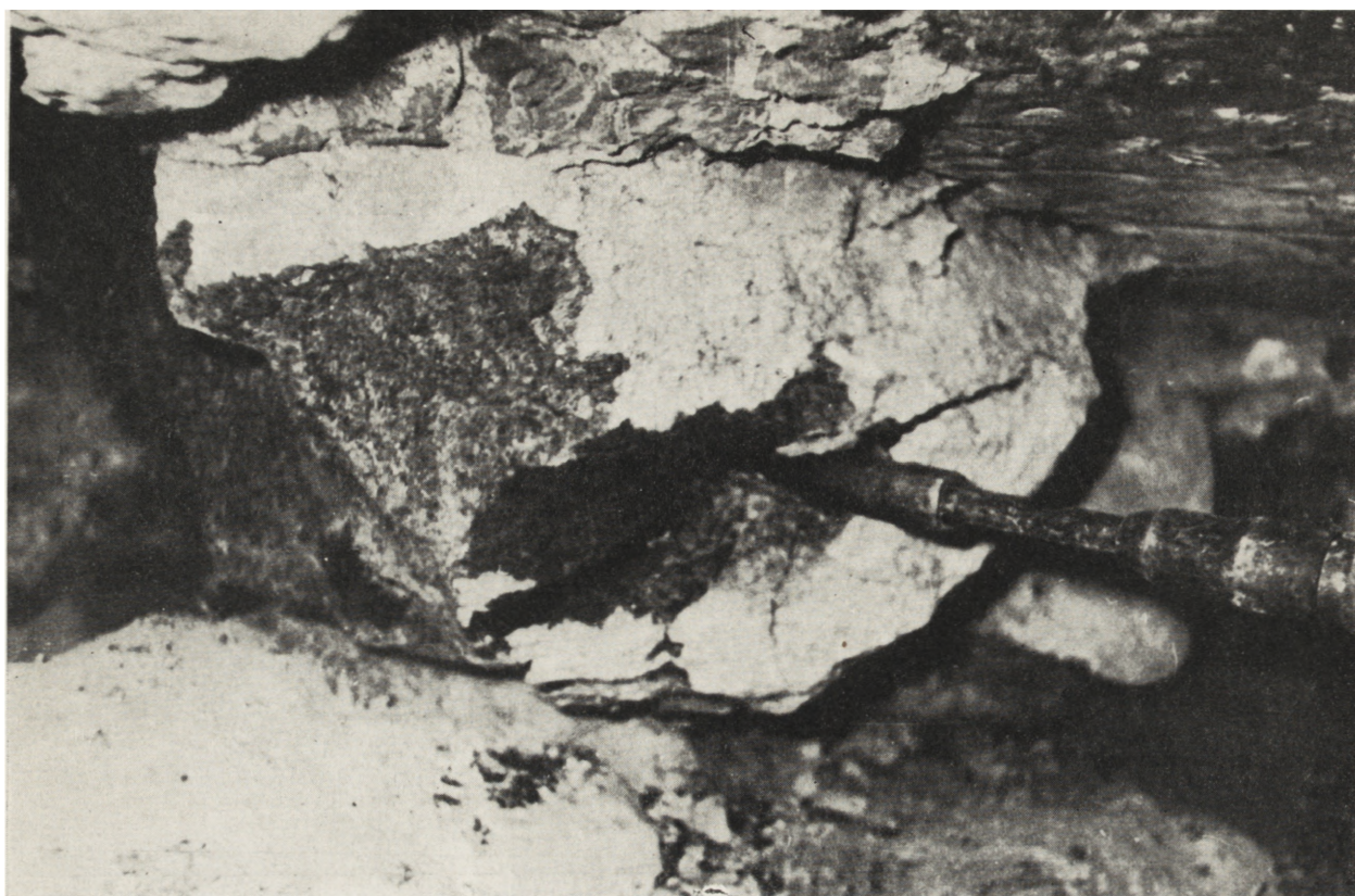
Ryc. 18. Warszawa, kościół NMP na Lesznie, rozłupywanie kamienia przy użyciu młotów pneumatycznych (fot. Jerzy Kotarski)
