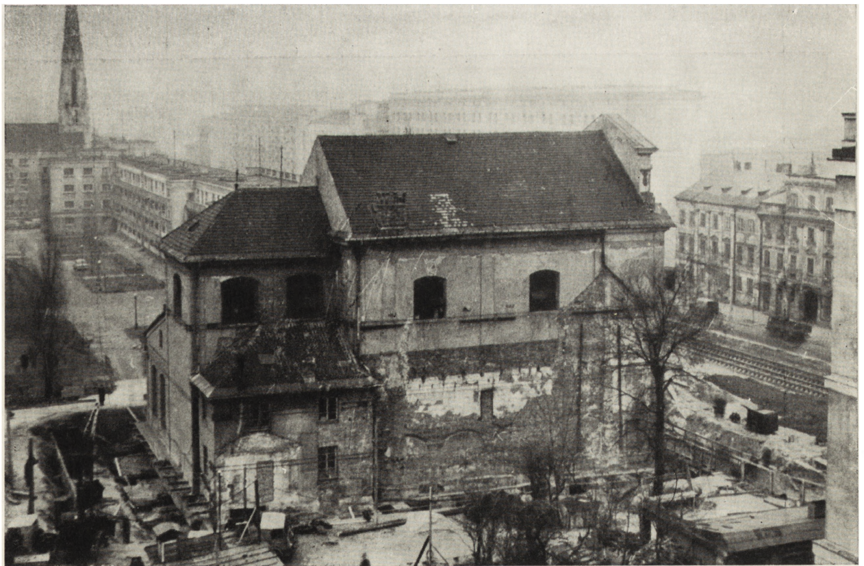
Ryc. 13. Warszawa kościół NMP na Lesznie, widok od strony zachodniej po przesunięciu (fot. Jerzy Kotarski)
