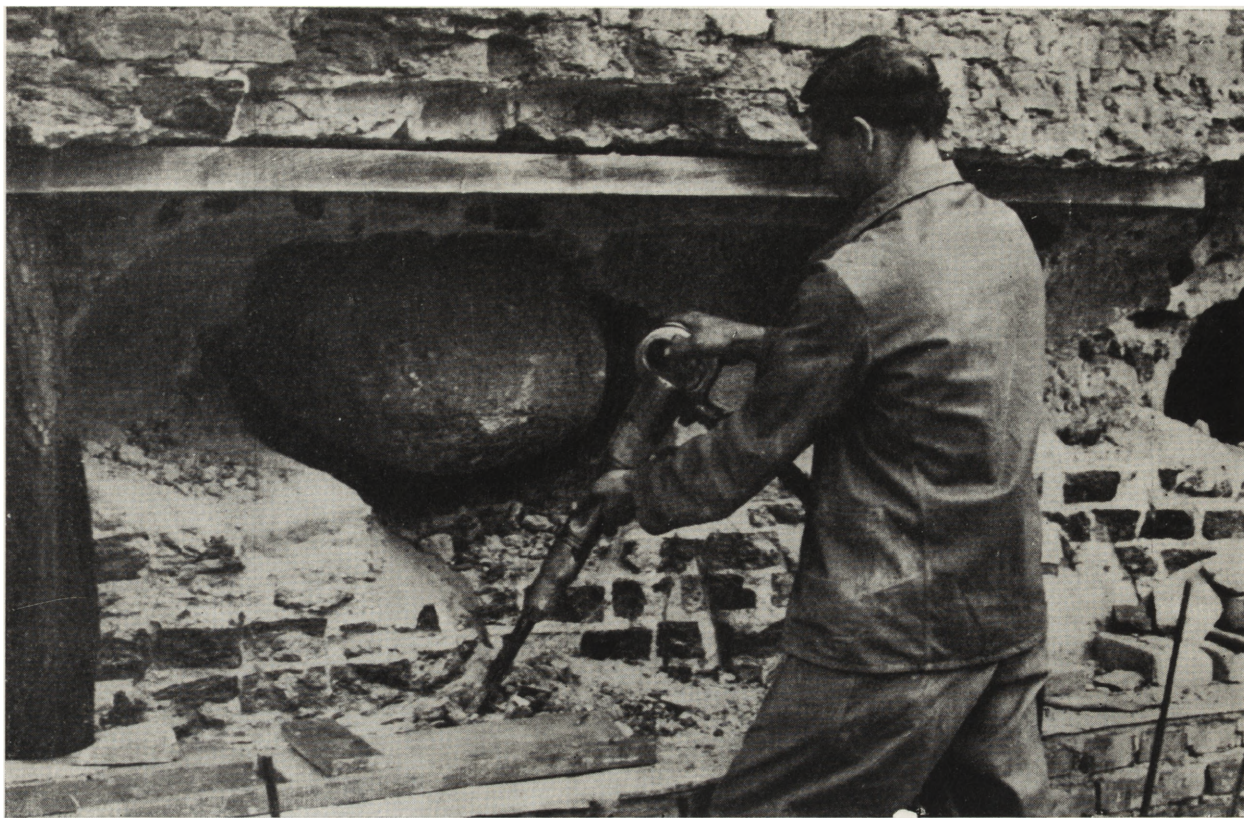
Ryc. 16. Warszawa, kościół NMP na Lesznie, wydobywanie kamieni z murów fundamentowych (fot. Jerzy Kotarski)
