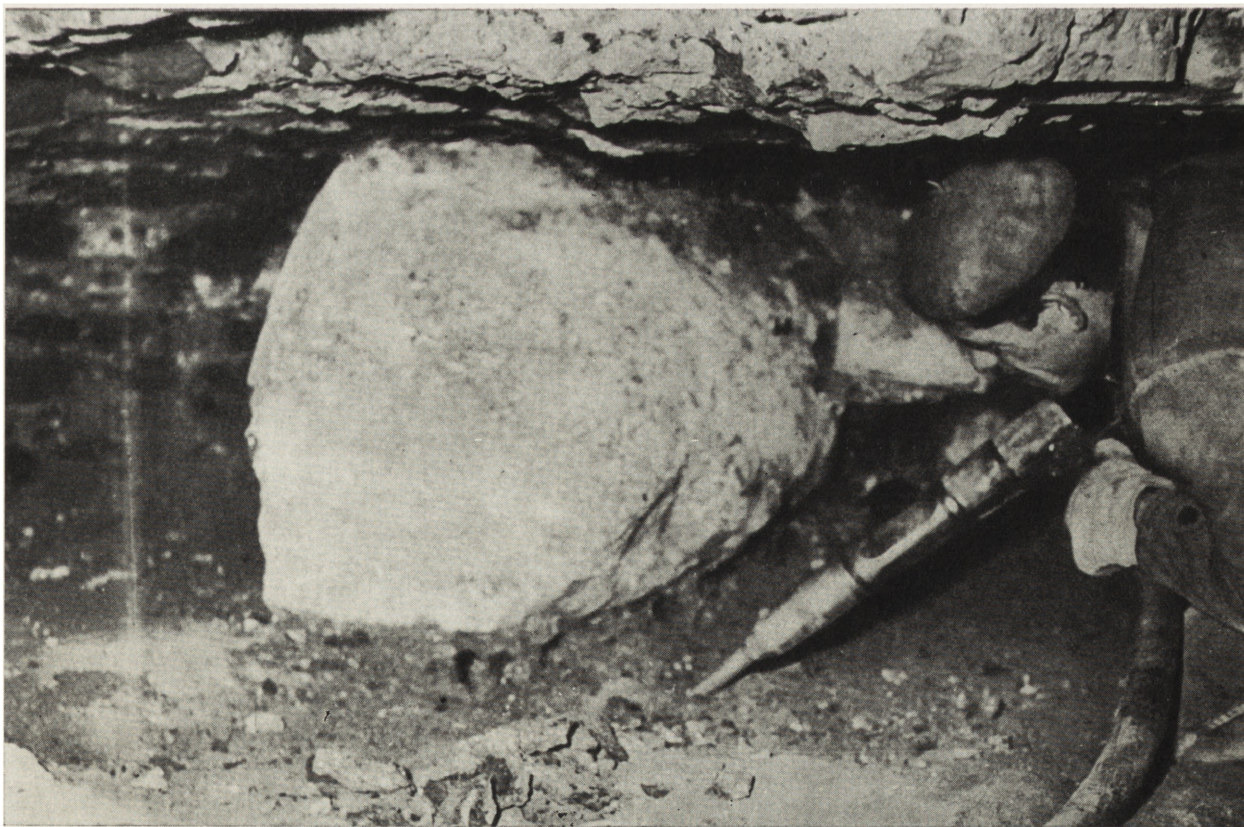
Ryc. 17. Warszawa, kościół NMP na Lesznie, podkopywanie kamienia pod filarem (fot. Jerzy Kotarski)
