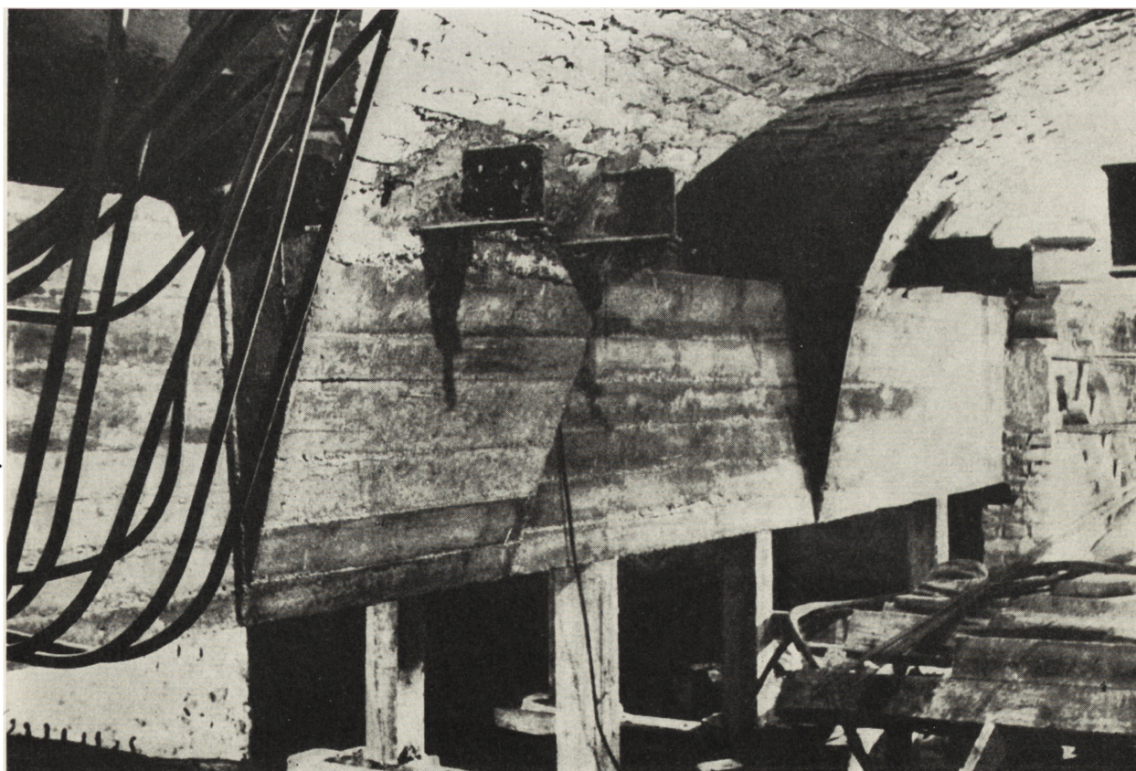
Ryc. 21. Warszawa, kościół NMP na Lesznie, żebro po zabetonowaniu
