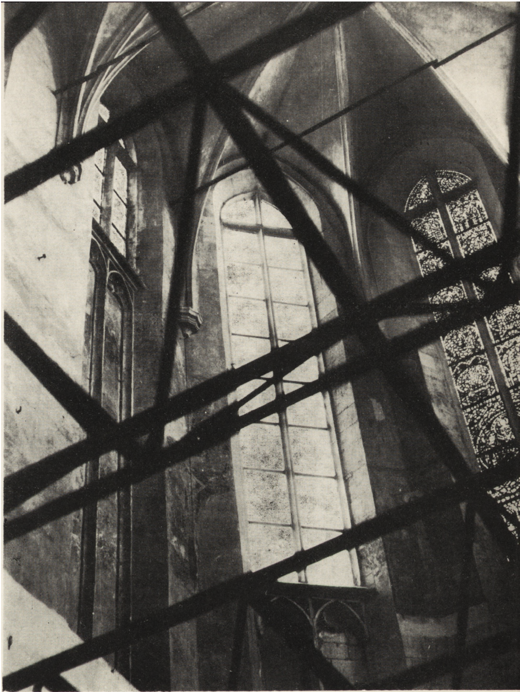
13. Kolegiata wiślicka. Fragment prezbiterium, widziany przez konstrukcję rozpierającą mury (Fot. E. Buczek 1960)
