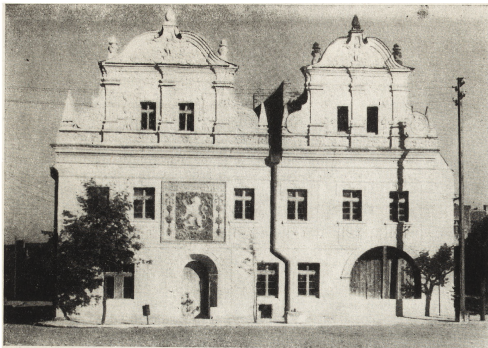
1. Bytom Odrzański. „Hotel pod Złotym Lwem”, stan surowy po odbudowie i konserwacji elewacji z 1962 r. (fot. S. Kowalski)
