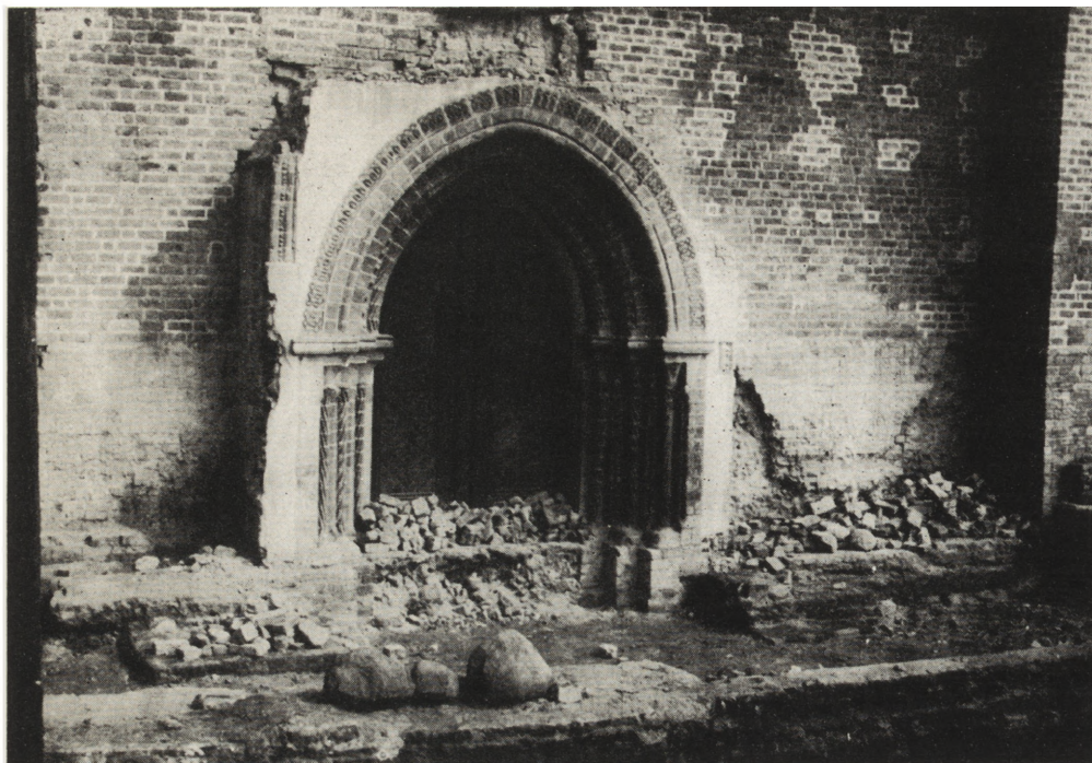
3. Poznań. Kościół poddominikański, portal po rozbiórce kruchty i odbudowy. Stan z 1958 r. (fot. autor)
