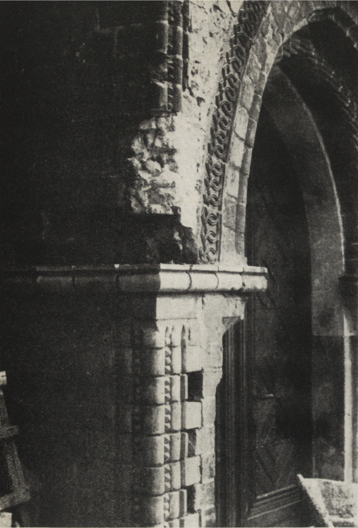
7. Poznań. Kościół poddominikański, uzupełnianie lewego boku występu portalowego (górną widoczne zachowane naroże) (fot. autor)
