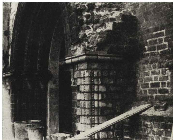
6. Poznań. Kościół poddominikański, uzupełnianie gzymsu prawego boku występu portalowego (fot. autor)
