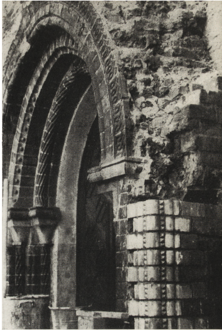
5. Poznań. Kościół poddominikański, prawy bok występu portalowego w trakcie rekonstrukcji. Stan z 1961 r. (fot. autor)
