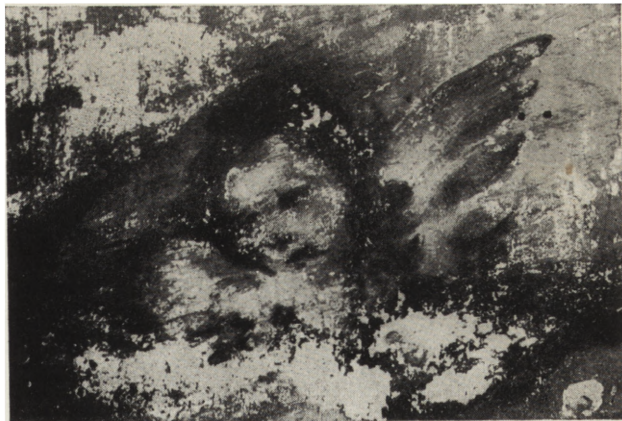
16. Polichromia na ścianie wschodniej. Fragment, stan przed konserwacją. Głowa anioła. Zniszczenia nastąpiły na skutek proszkowania się oraz drobnych złuszczeń warstwy malatury (fot. A. Czerepiński)
