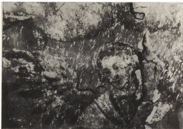
18. Fragment polichromii na ścianie wschodniej, stan przed konserwacją. Widoczne ubytki zaprawy i wątku muru spowodowane ostrzałem artyleryjskim w czasie ostatniej wojny. Zdjęcie wykonane w oświetleniu skośnym (fot. A. Czerepiński)
