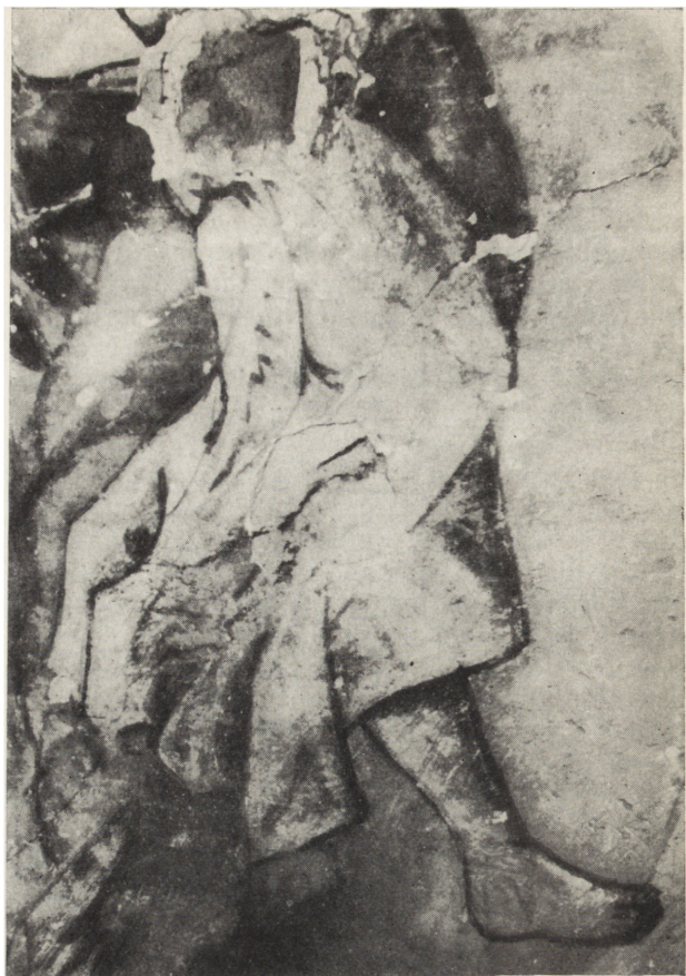
20. Fragment polichromii na ścianie wschodniej, stan przed konserwacją (fragment postaci anioła). Widoczny u dołu ubytek warstwy malarskiej wraz z pobiałkami; u góry — ubytek zaprawy i zniszczenie wątku muru. Na nodze anioła i szacie widoczne w wielu miejscach wtórne malowanie konturów (fot. A. Czerepiński 1965 r.)
