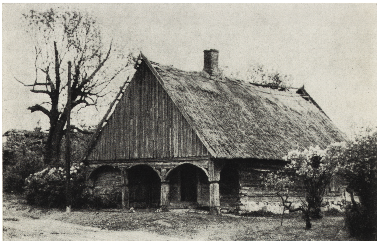
8. Pułkowo-Wielkie, pow. Wąbrzeźno, chata — stan z 1960 r. (fot. C. Kuchta)
