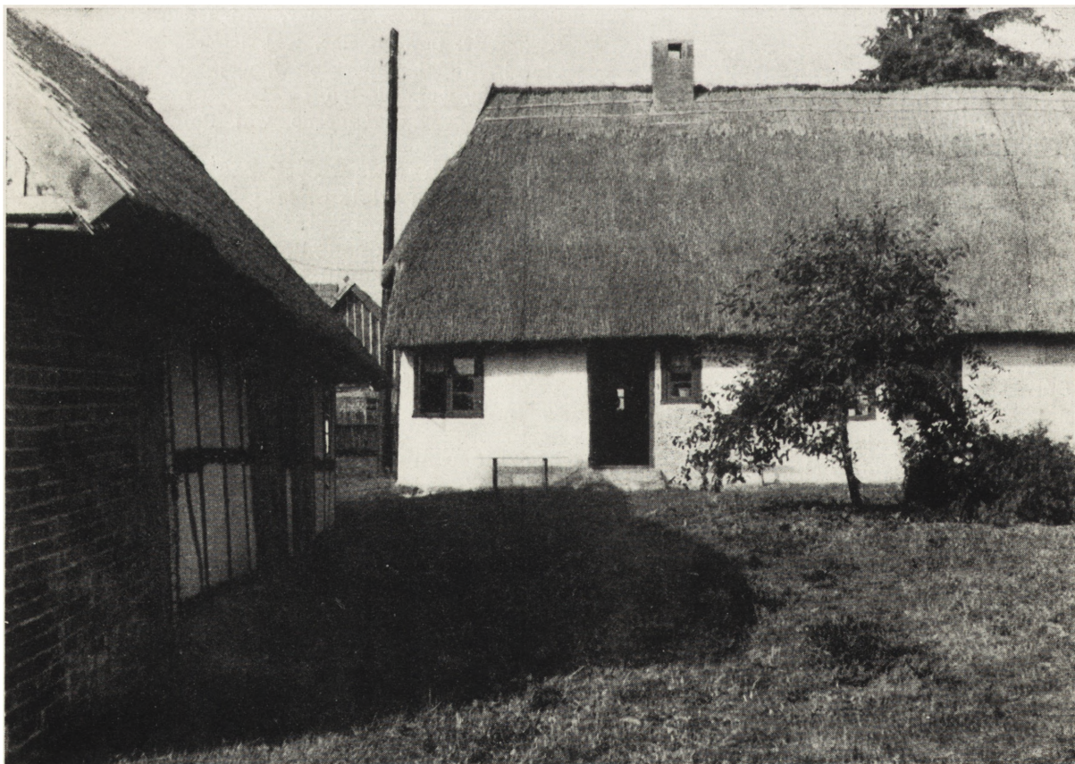
2. Kluki, pow. Słupsk, skansen — stan z 1963 r. (fot. F. Ptaszyński) 2. Kluki, distr. Słupsk, skansen, état en 1963
