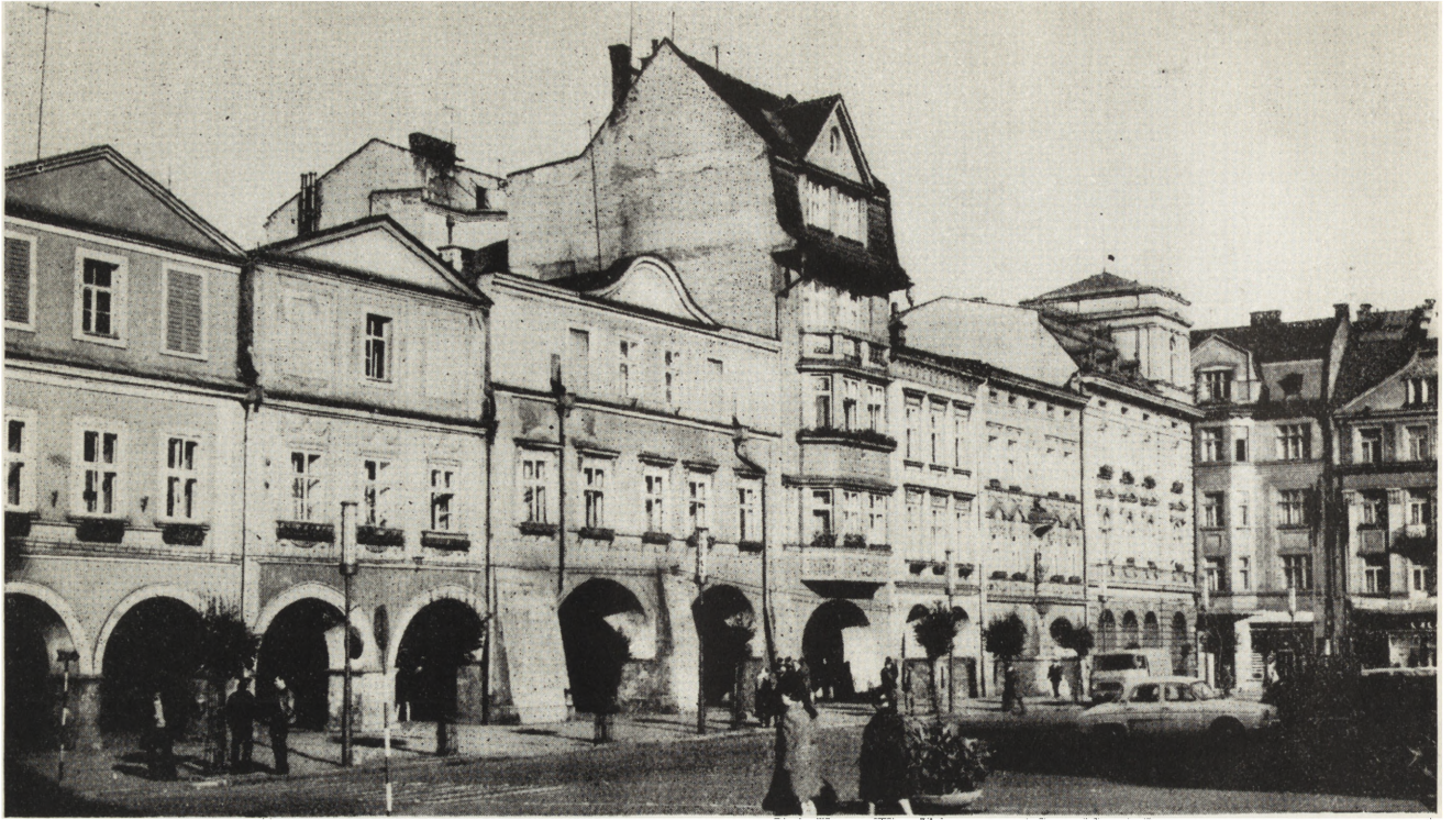
6. Cieszyn, zabudowa zach. pierzei Rynku (fot. T. Kaźmierski) 6. Cieszyn, buildings on the Market west frontage
