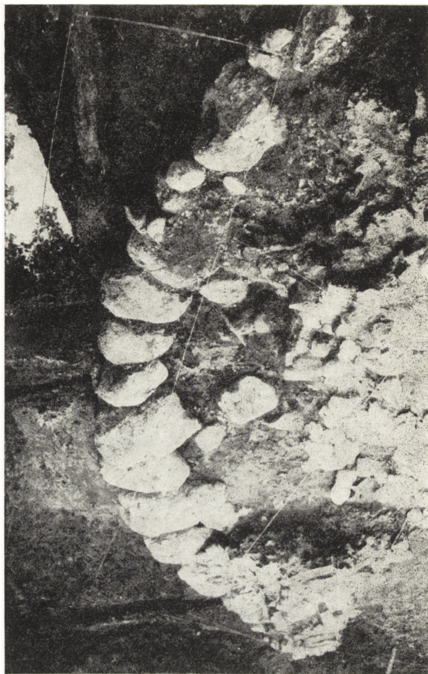
2. Sieradz, rotunda, fundament południowej części nawy i przylegające do jego lica konstrukcje drewniane wału z XIII—XIV wieku (fot. K. Nowiński)
