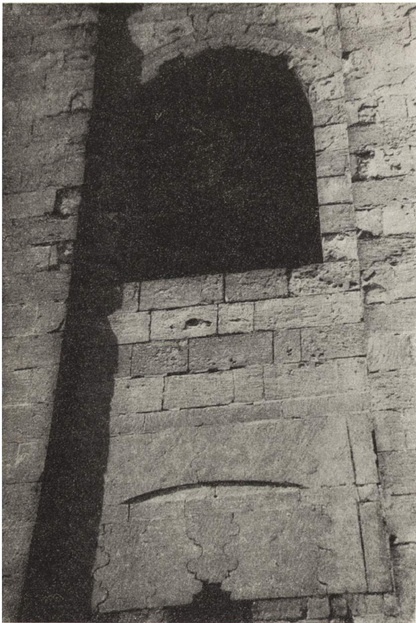
2. Kair, meczet Emira Kurkumasa, elewacja południowa mauzoleum, widoczny układ okładziny nadproży okien parteru i układ klinców okna I piętra (fot. S. Siarkiewicz)
