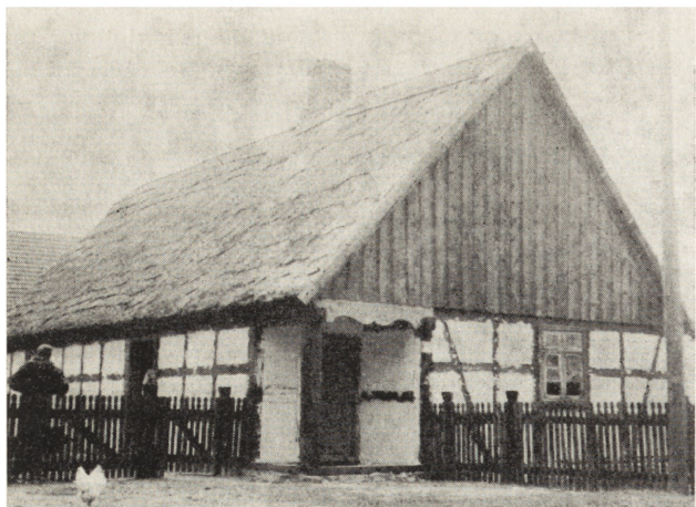
10. Stara Święta (pow. Złotów), chałupa nr 98 w czasie prac konserwatorskich — 1972 r. (fot. A. Mosiewicz)
