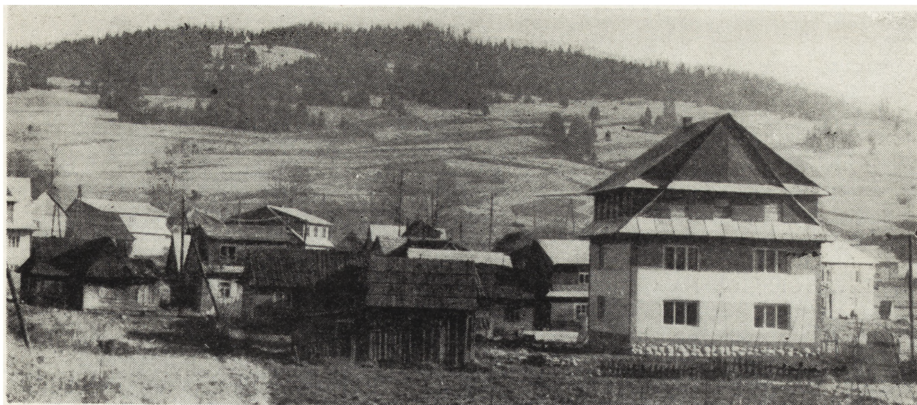
5. Czarna Góra, pow. Nowy Targ; osiedle cygańskie z nowo wybudowanym domem 5. Czarna Góra, Nowy Targ district; gypsy settlement with a newly erected house
