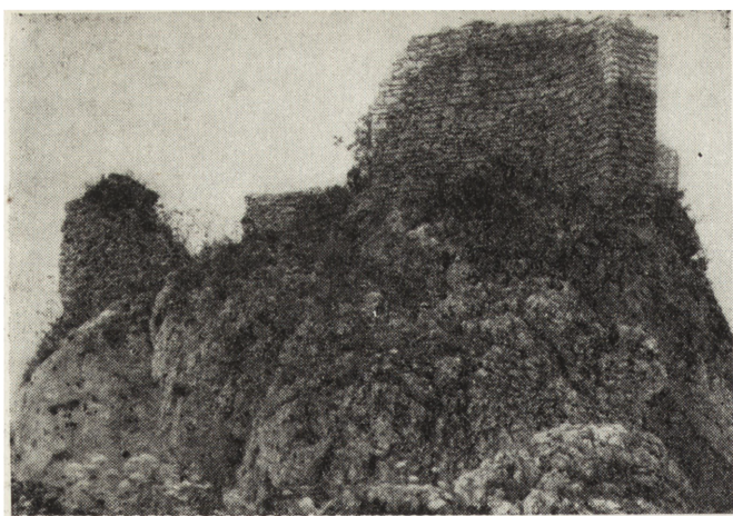
3. Dzieło: Ryczów — prawidłowa konserwacja wzmacniająca koronę muru i zachowująca jej wątek i charakter. Zwraca uwagę nie naruszanie otoczenia, nawet drobne krzewy pozostały na miejscu.
