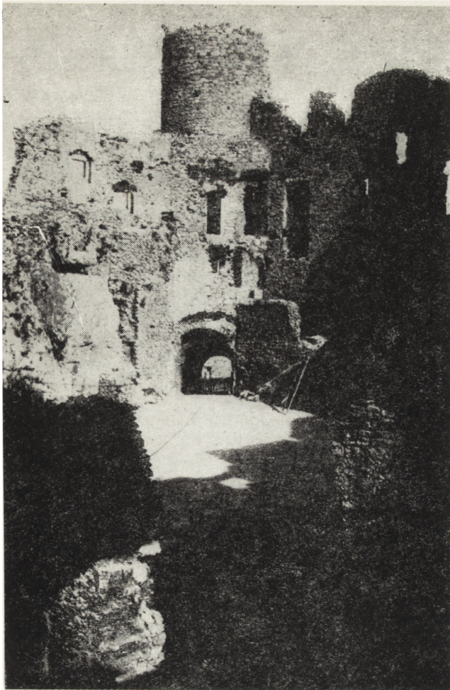
2. Zamek ogrodzieniecki, widok baszty bramnej od północy (fot. A. Gruszecki)
