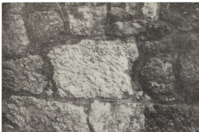
4. Zamek ogrodzieniecki, oznaczenie paskiem blachy umieszczonej w spoinie granicy starego i nowego muru (fot. A. Gruszecki)
