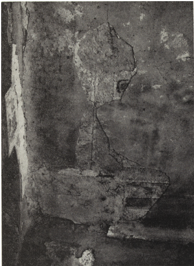
8. Gułtowy, pałac, sala balowa, stan zachowania pierwotnych tynków na stropie (fot. R. Banikowski)
