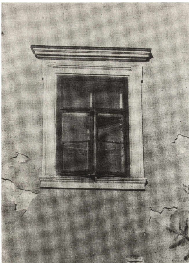
8. Kruszyzna, okno na piętrze w południowej elewacji pałacu, stan w 1977 r. (fot. J. Mielczarek)
