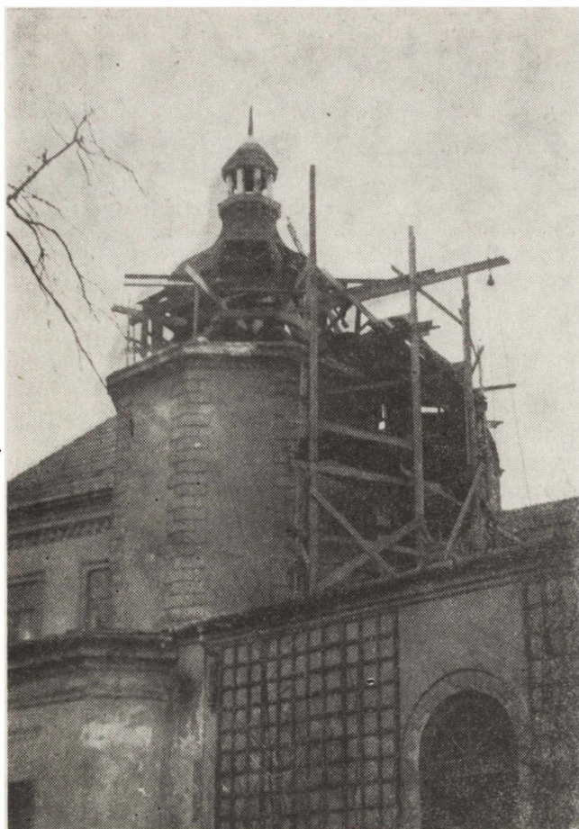
9. Kruszyna, wieża zachodnia palacu, stan w 1971 r. (fot. J. Augustyniak)
