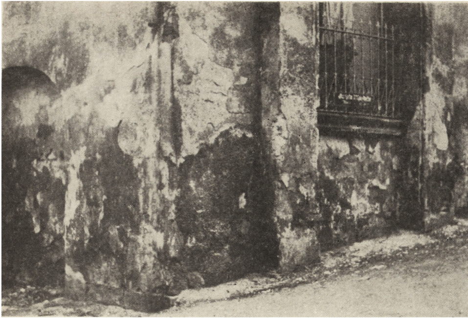
9. Wambierzyce, fragment ściany kaplicy Najświętszego Serca Jezusa (fot. J. Sajdera, 1979 r.)
