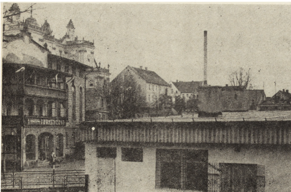
17. Wambierzyce, widok z Góry Nowej na dach pawilonu handlowego (fot. J. Sajdera, 1979 r.)
