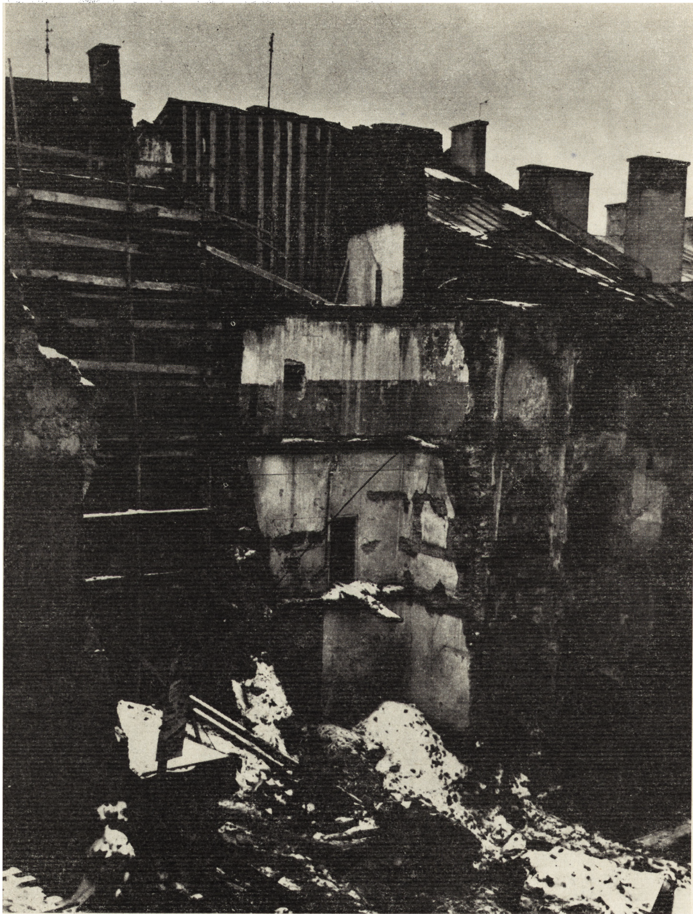
9. Lublin, widok tyłów kamienic przy ul. Grodzkiej 3, 5, 5a po rozebraniu oficyn (fot. A. Krzak)
