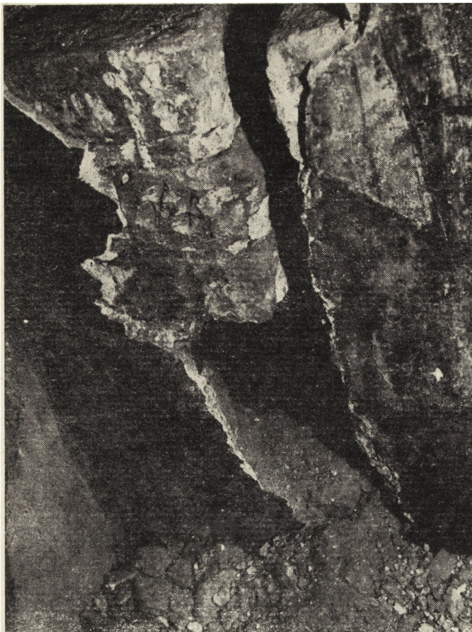
6. Lublin, kaplica zamkowa Trójcy Św., południowa ściana nawy — dolna (przy posadzce) część szczeliny, przechodzącej do wnętrza muru w obszerną kavernę, po oczyszczeniu z gruzu (fot. T. Ptaszński)
