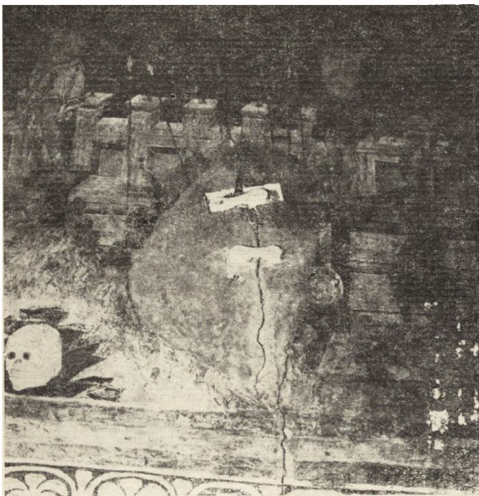
4. Lublin, kaplica zamkowa Trójcy Św., południowa ściana prezbiterium: A — rysy pionowe na tynku (widoczne plomby kontrolne) stanowiącym naprawę z lat 1917—1918; B — nie zidentyfikowany otwór uwidoczny po usunięciu naprawy (fot. T. Ptasński)
