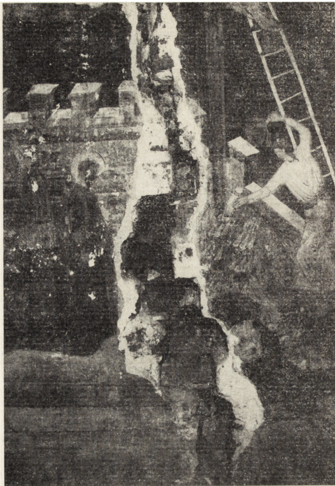
1. Lublin, kaplica zamkowa Trójcy Św., południowa ściana prezbiterium: A — rysa pionowa na tynku (widoczne plomby kontrolne) stanowiącym naprawę z lat 1917—1918 (fot. T. Ptasieński); B — szczelina w murze powstała po usunięciu naprawy (fot. J. Urbanowicz)
