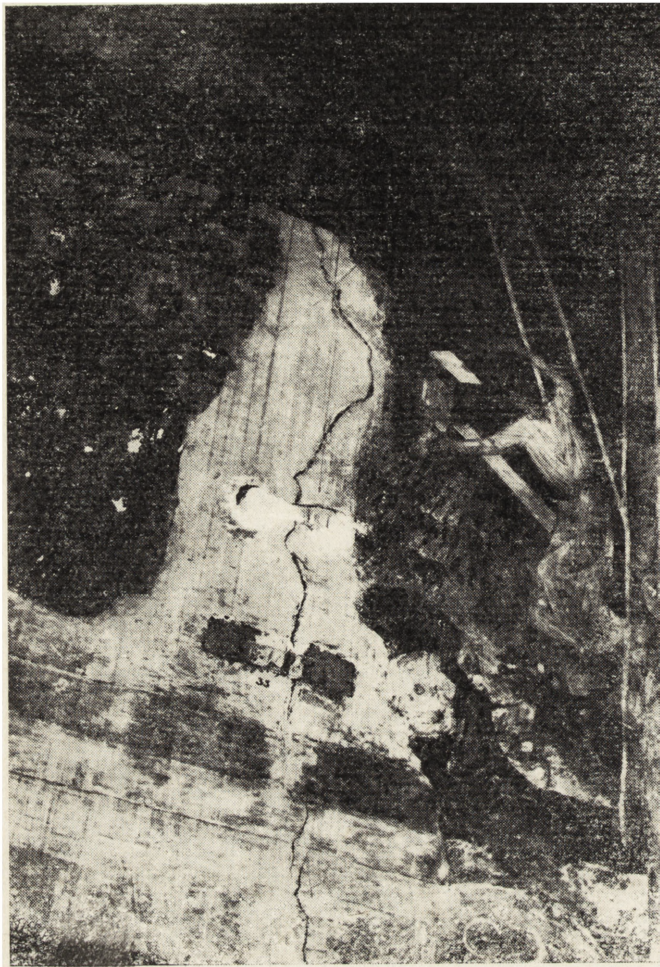
1. Lublin, kaplica zamkowa Trójcy Św., południowa ściana prezbiterium: A — rysa pionowa na tynku (widoczne plomby kontrolne) stanowiącym naprawę z lat 1917—1918 (fot. T. Ptasieński); B — szczelina w murze powstała po usunięciu naprawy (fot. J. Urbanowicz)
