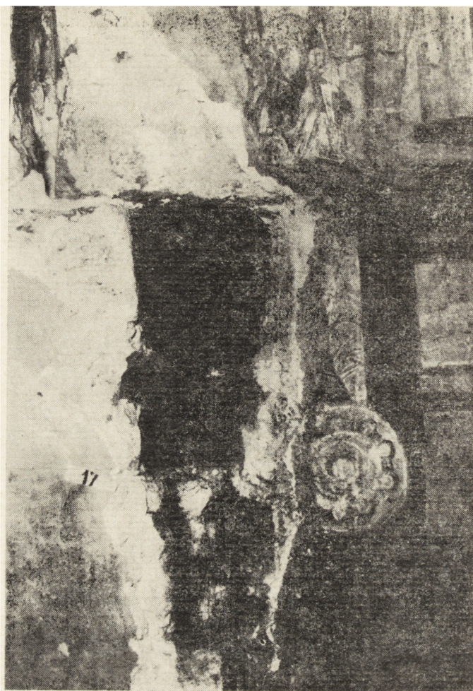
4. Lublin, kaplica zamkowa Trójcy Św., południowa ściana prezbiterium: A — rysy pionowe na tynku (widoczne plomby kontrolne) stanowiącym naprawę z lat 1917—1918; B — nie zidentyfikowany otwór uwidoczny po usunięciu naprawy (fot. T. Ptasński)
