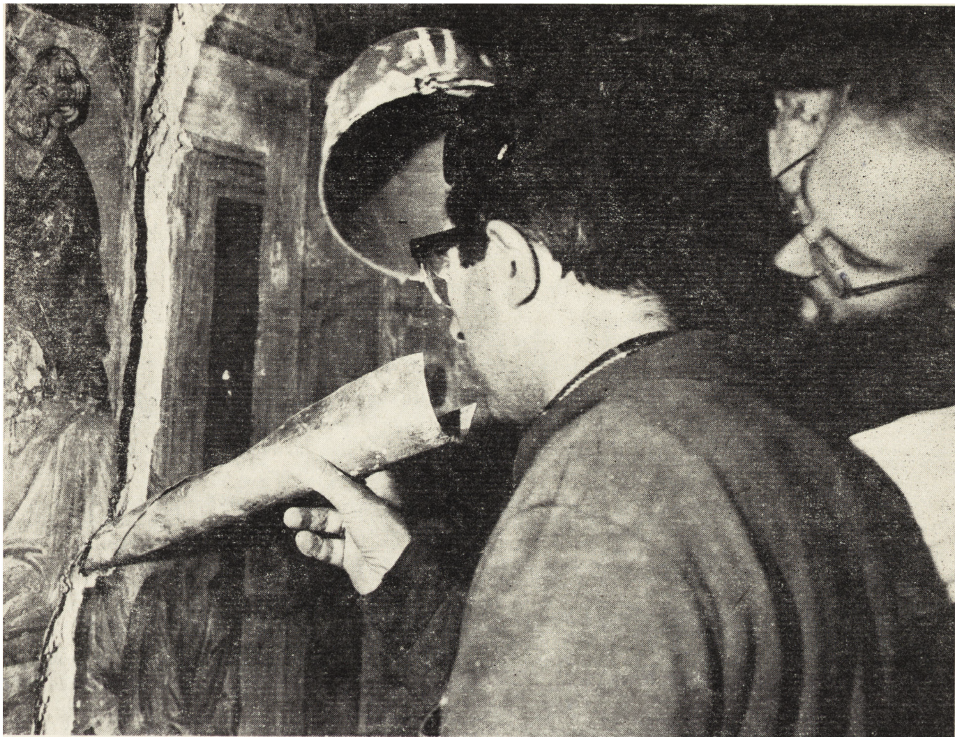
7. Lublin, kaplica zamkowa Trójcy Św., północna ściana prezbiterium — wykonanie zalewki z rzadkiej zaprawy o własnościach hydraulicznych (fot. T. Ptasiński)
