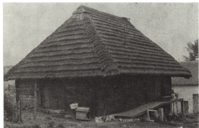
4. Blizne, lamus po zakończeniu prac remontowych (fot. Z. Gil, 1980 r.)
