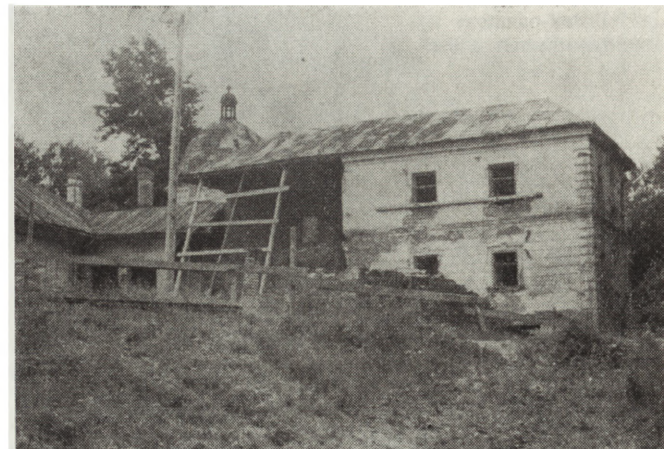
10. Kombornia, oficyna dworska w trakcie prowadzenia prac zabezpieczających (fot. Z. Gil, 1981 r.)
