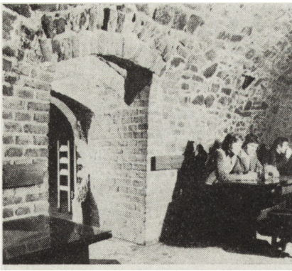
7. Krosno, piwnice kamienicy „Wójtowskiej” adaptowane na kawiarnię (fot. M. Głowiński)
