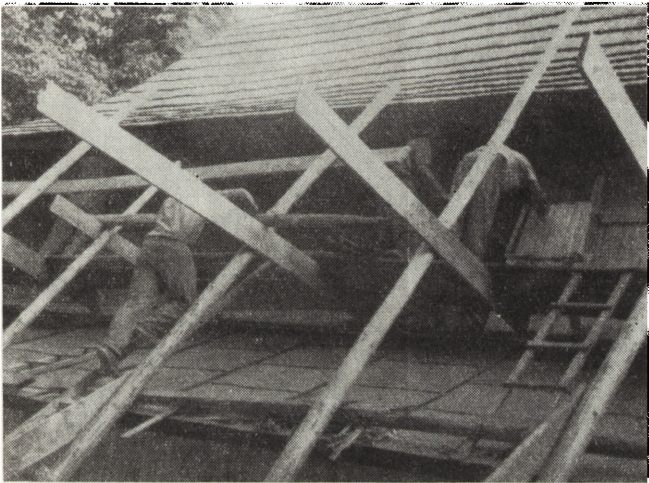
13. Osiek Jasielski, prace konserwatorskie przy drewnianym kościele (fot. Z. Gil, 1979 r.)
