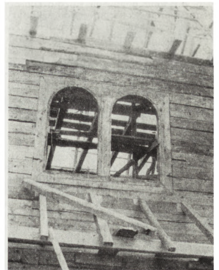
14. Lutowiska, cerkiew, montaż obiektu po przeniesieniu do Dwernika (fot. Z. Gil, 1980 r.)
