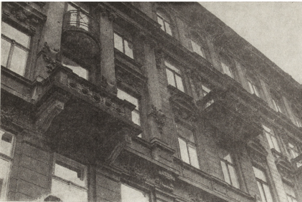
13. Fragment elewacji eklektycznej, ul. Nowogrodzka 44 (fot. A. Gruszecki)
